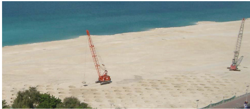
Şekil 2.6 : Bir kıyı dolgusunun dinamik kompaksiyon ile sıkıştırılması ( http://www.menard-web.com/Appli/intranet/referencesms.nsf/ ).
