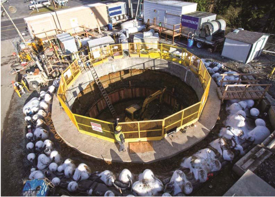
Şekil 2.7 : Şaft kuyusu açımında zemin dondurma ( http://www.moretrench.com/services/ground-freezing/ ).
