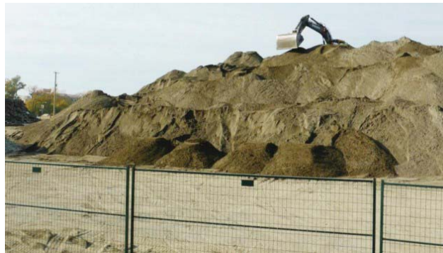
Şekil 2.2 : Yüksek katlı yapı inşaatı öncesi sahada önyükleme çalışması ( http://www.intracorp.ca/riverparkplace/river-park-place-construction-series/ ).
