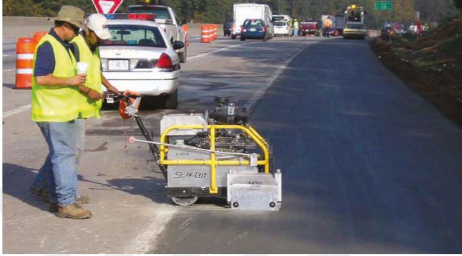
Şekil 3.12: SSB tabakada enine derz kesilme işlemi
