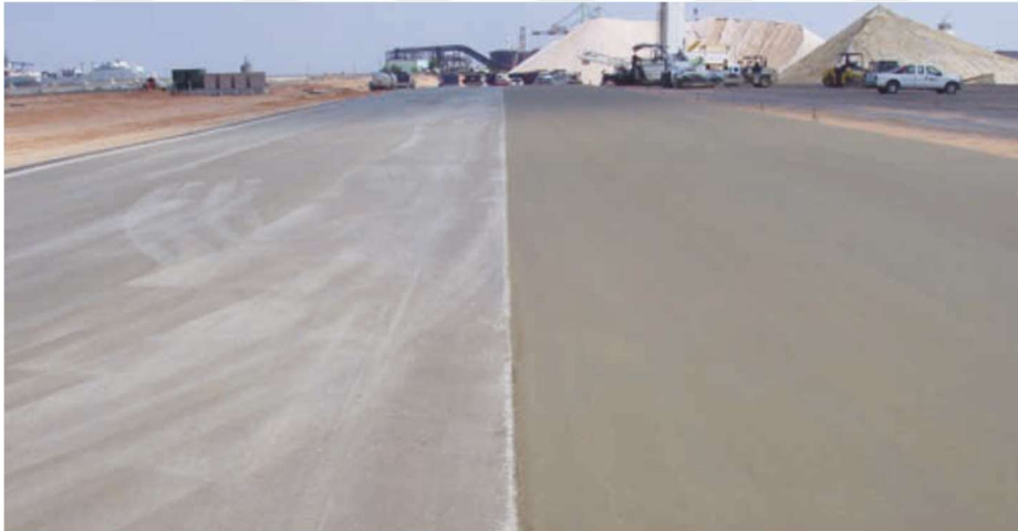
Şekil 3.13: SSB tabakada oluşturulan boyuna derz
