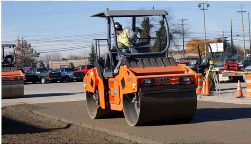
Şekil 3.11: SSB karışımın çift tamburlu titreşimli silindirler ile sıkıştırılması
