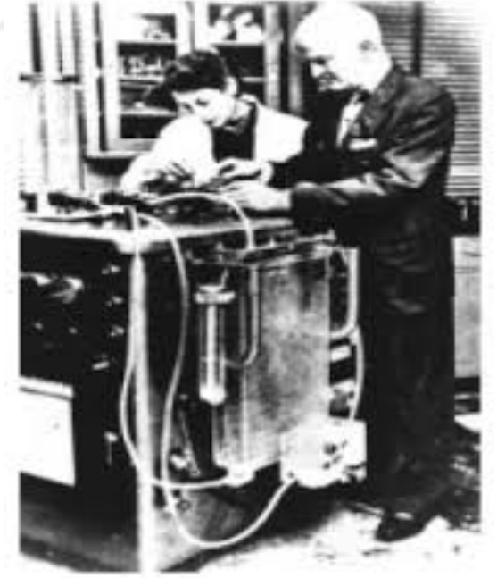
Şekil -4: John Heysham Gibbon'un geliştirdiği ilk Kalp-Akciğer Makinesi
