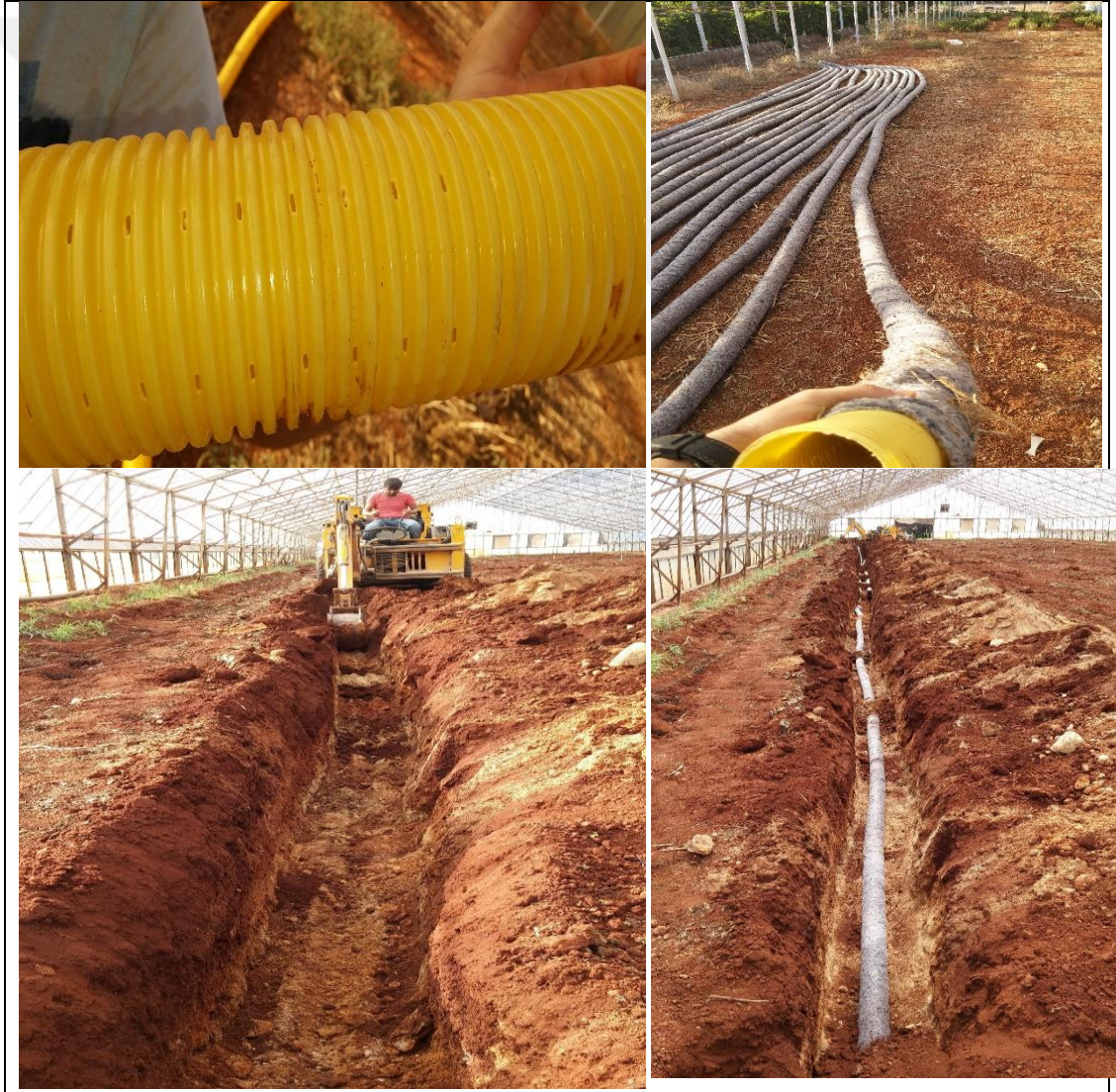
Şekil 3.2. Drenaj boru hattı uygulama fotoğraf gösterimi
