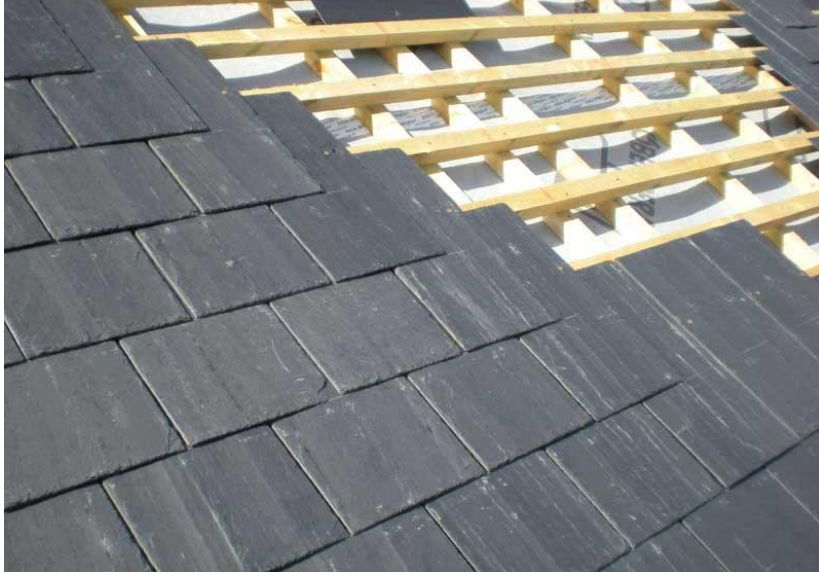
Resim 22. Sleytin çatı örtüsü olarak kullanımı
