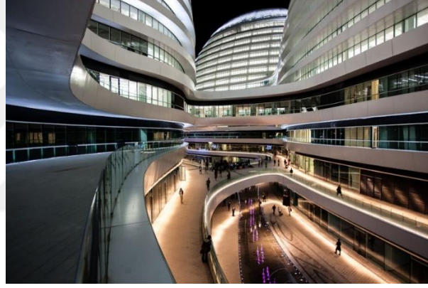
Görsel 1.8. Galaxy Soho alışveriş merkezi cephe görünümü
