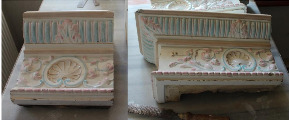
Görsel 2.14. Özel olarak şekillendirilmiş alınlıklı düz ve alınlıklı köşe karosu. Dolmabahçe Sarayı (Fotoğraf: Kamuran AK, 2015)
