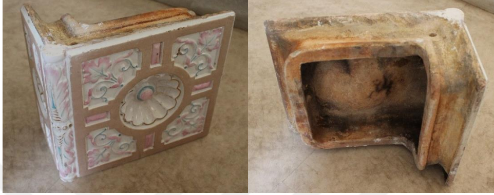
Görsel 2.13. Özel olarak şekillendirilmiş köşe dönüş karosu. Dolmabahçe Sarayı (Fotoğraf: Kamuran AK, 2015)
