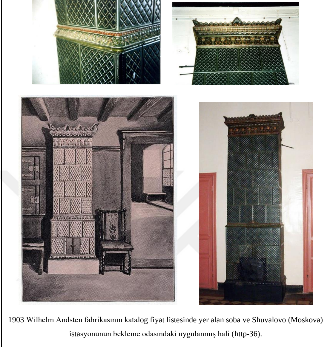
Görsel 2.38. Dikdörtgen formu, rölyefli, sırlı karolardan inşa edilmiş seramik soba ( http-36 )
