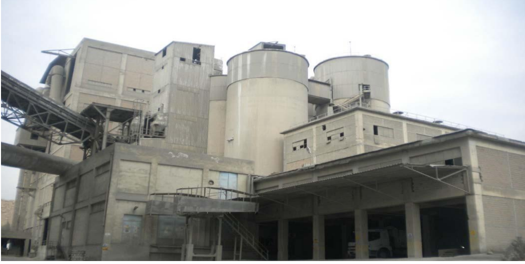
Resim 2.11 Çimento siloları ve paketleme ünitesi.
