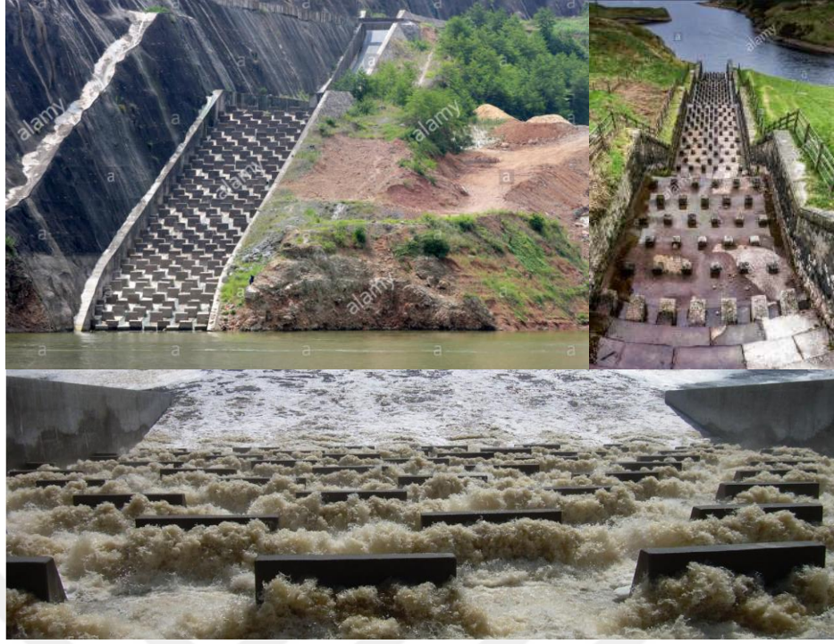
Şekil 3.1 : Şüt kanalı uygulamalarında akımın hareketi (Baffled spillway, Maple River Dam Overflow Chute. Erişim: 27 Mayıs 2021).
