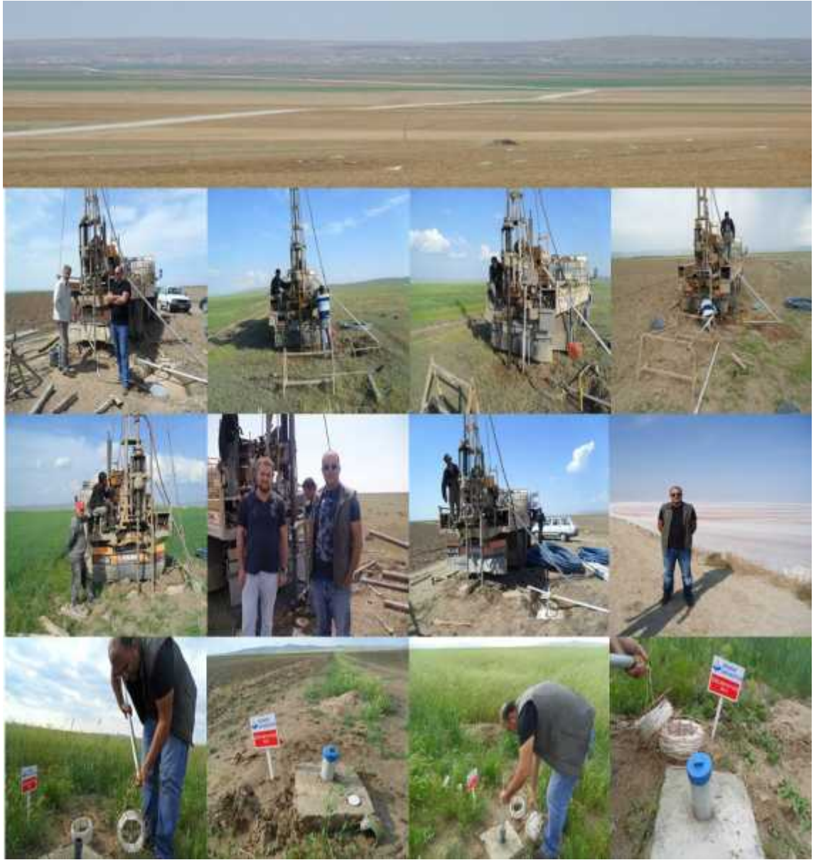
Şekil 5.17. İnceleme alanında araştırma sondajlarının açım çalışmaları
