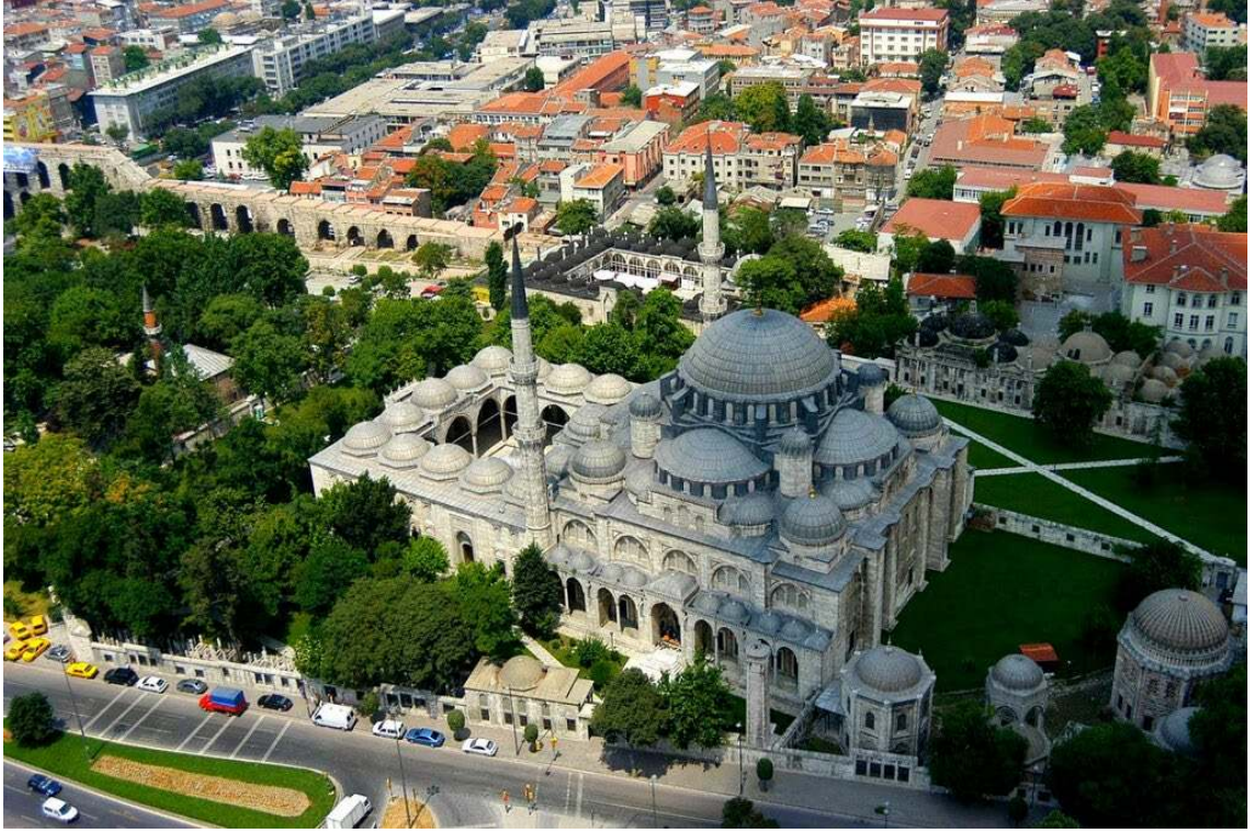
Şekil 2.5. Şehzade Mehmet Külliyesi [36].
