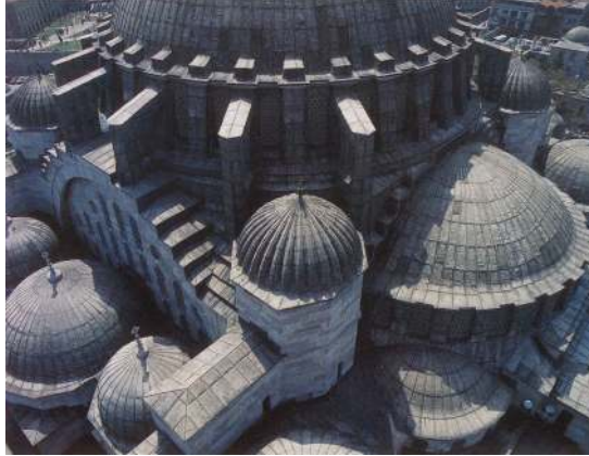
Şekil 3.22. Süleymaniye Camii'nin ana kubbesi ve geçiş elemanları [3].
