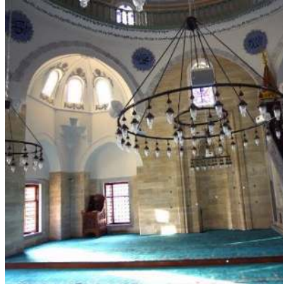
Şekil 3.19. Tekirdağ Rüstem Paşa Camii trompunun yapı içinden fotoğrafı [103].
