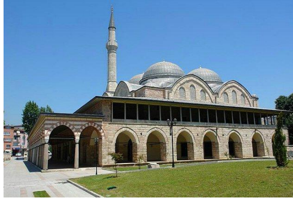
Şekil 2.3. Piyale Paşa Camii [31].
