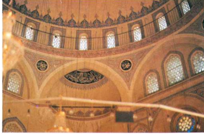
Şekil 2.34. Pertev Paşa Camii Kubbesi ile kasnak duvarlarının birleşimi detayı [69].
