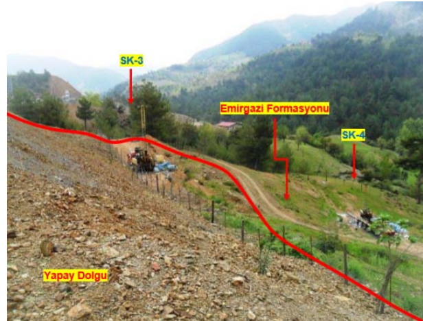
Şekil 4.17. İnceleme alanında bulunan zemin tabakaları ve yapılan sondaj çalışmaları
