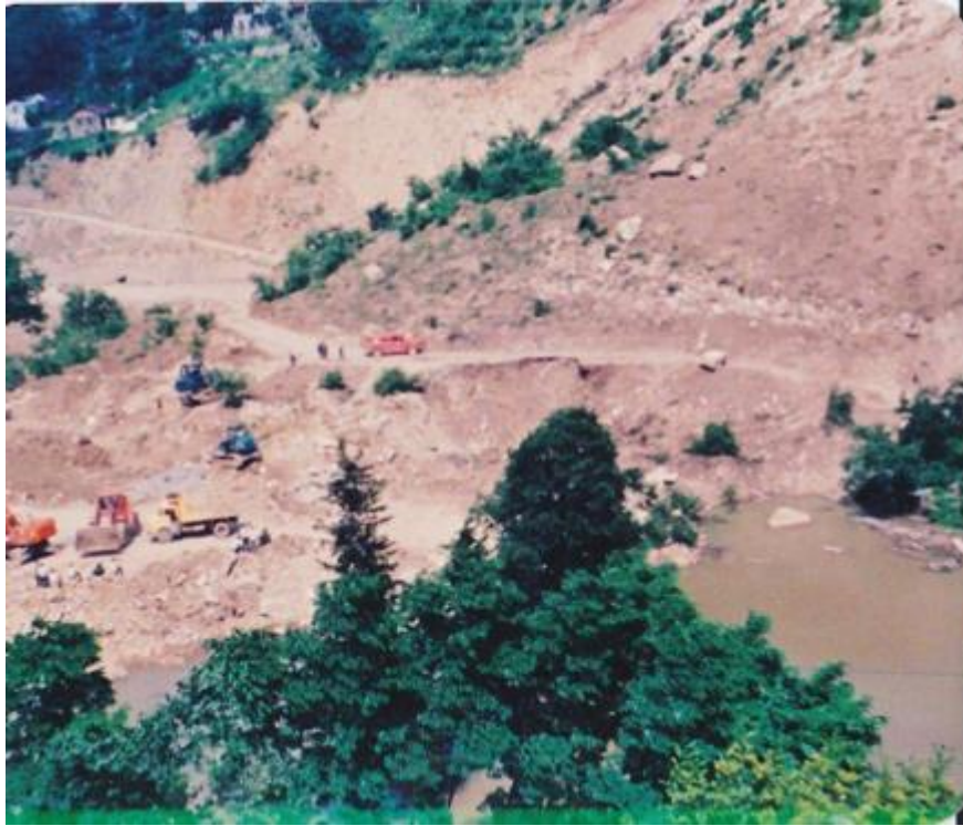
Şekil 5. Trabzon’un Maçka ilçesinde meydana gelen heyelan (URL-1, 2021)
