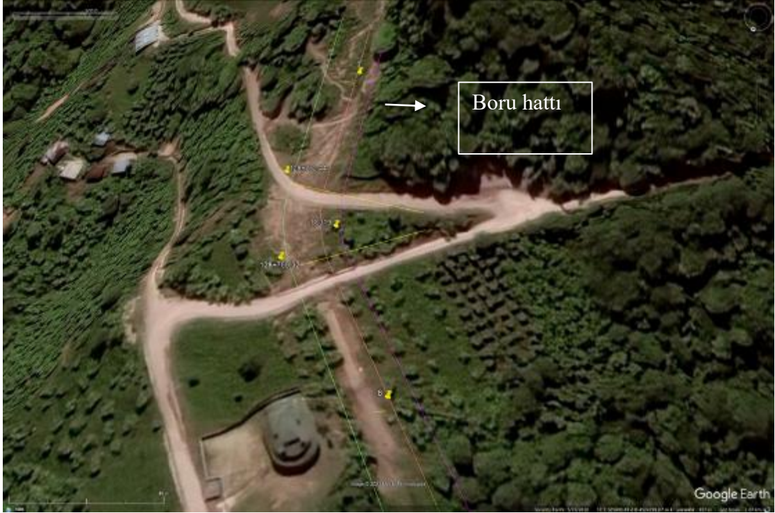
Şekil 36. 2010 yılında boru hattı inşasının yapıldığı alanın Google Earth uydu görüntüsü (URL-4, 2024)
