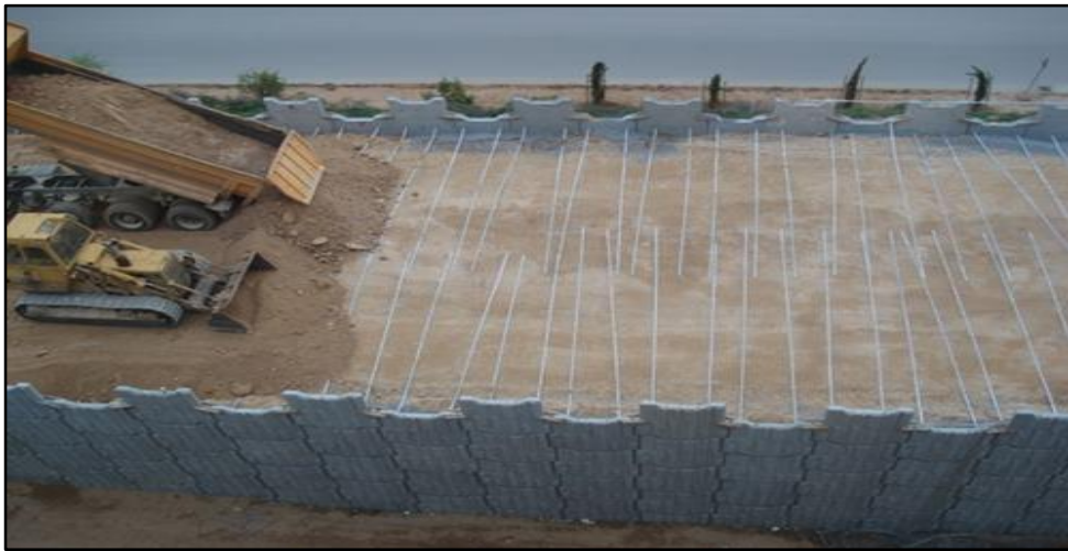
Şekil.3.9. Donatılı duvar ( https://sanalsantiye.com/ )
