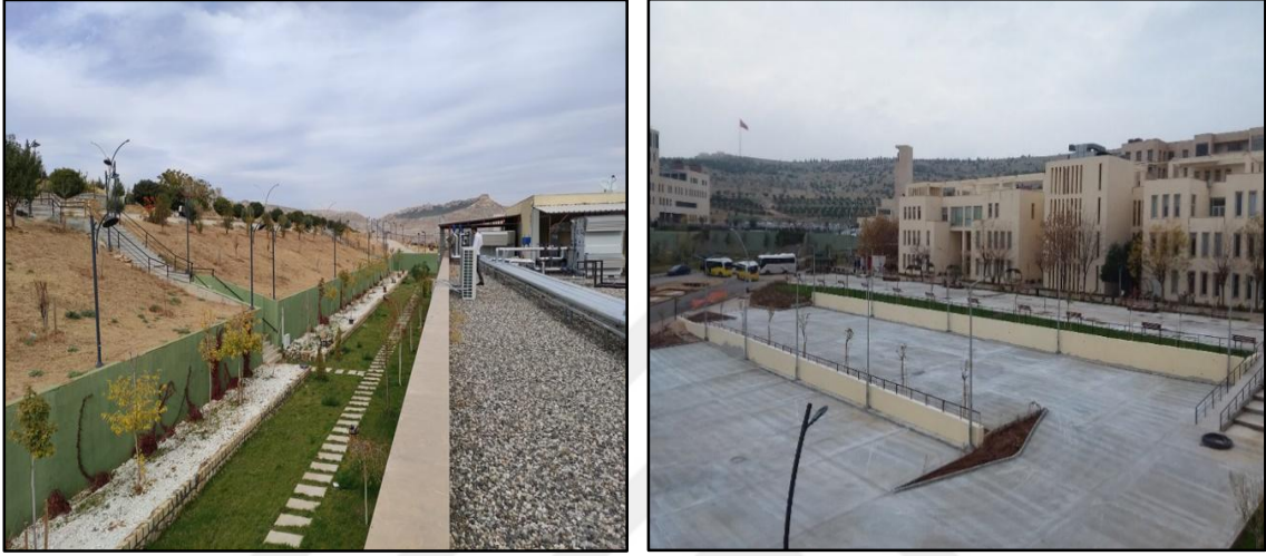
Şekil.3.5. Konsol istinat duvarı örneği (MAÜ Yerleşkesi)
