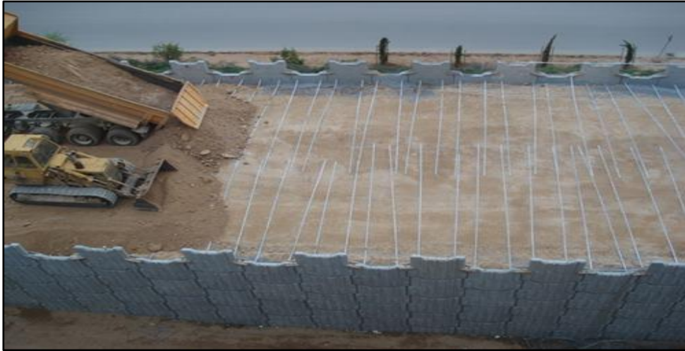
Şekil.3.9. Donatılı duvar ( https://sanalsantiye.com/ )
