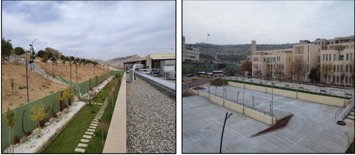
Şekil.3.5. Konsol istinat duvarı örneği (MAÜ Yerleşkesi)
