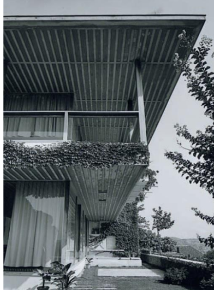
Şekil 3.21. Safyurtlu II Köşkü görünüş
