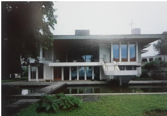
Şekil 3.34. Koç Köşkü Boğaz'a bakan cephe
