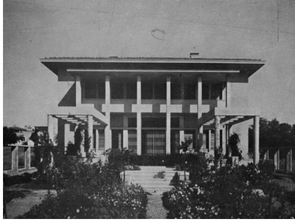
Şekil 3.14. Salih Bozok Villası deniz cephesi
