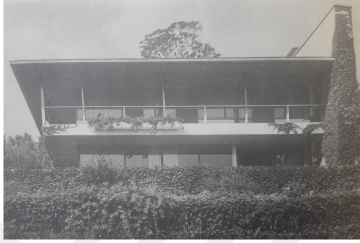
Şekil 3.20. Safyurtlu II Köşkü görünüş
