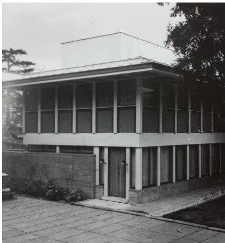
Şekil 3.25. Uşaklıgil Köşkü giriş
