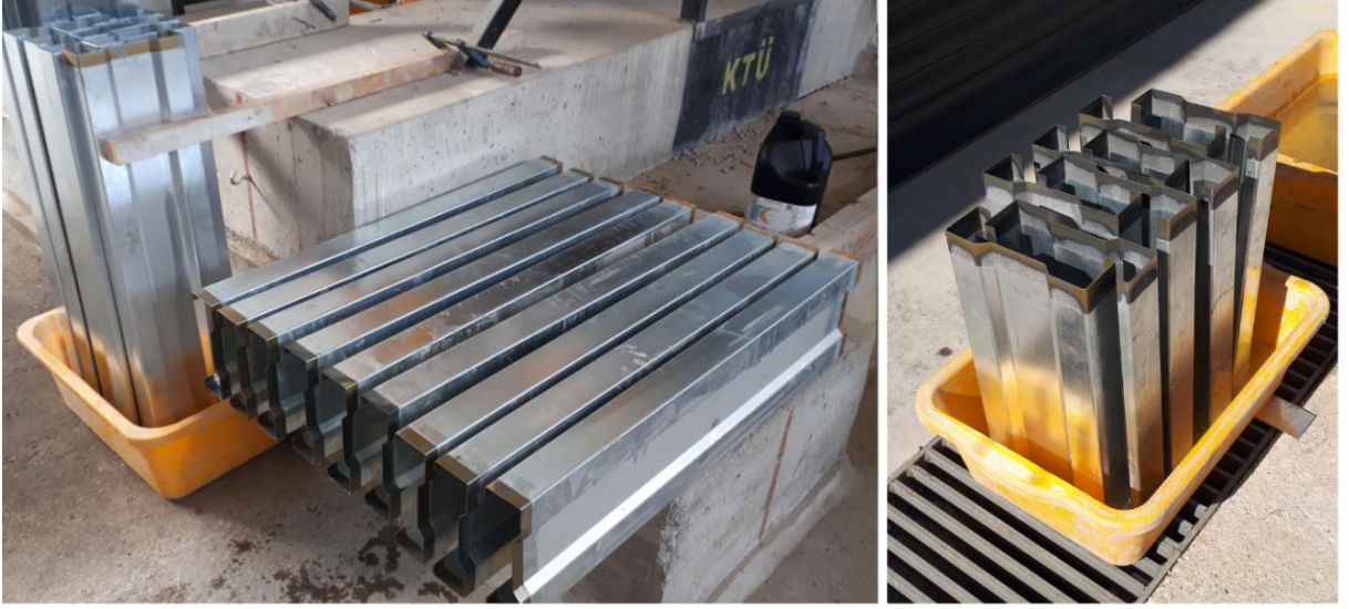
Şekil 30. Profillerin kaynaklama bölgesinde asit banyosu işlemi
