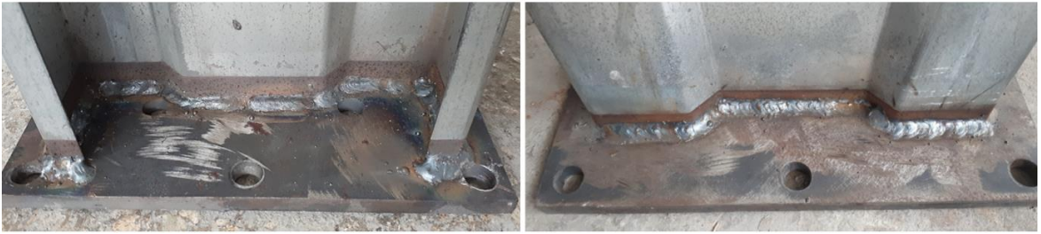
Şekil 31. Profil - başlık levhası kaynak dikişleri
