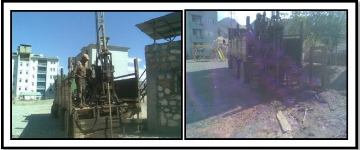
Şekil 5.2. İnceleme alanında yapılan sondaj çalışmaları.
