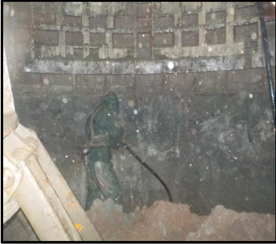
Şekil 4.15. İnceleme alanındaki üretim kuyusunda yapılan tarama
