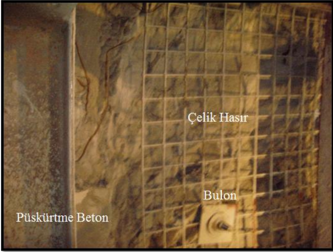
Şekil 4.16. Püskürtme beton işlemi sonrası çelik hasır ve blon
