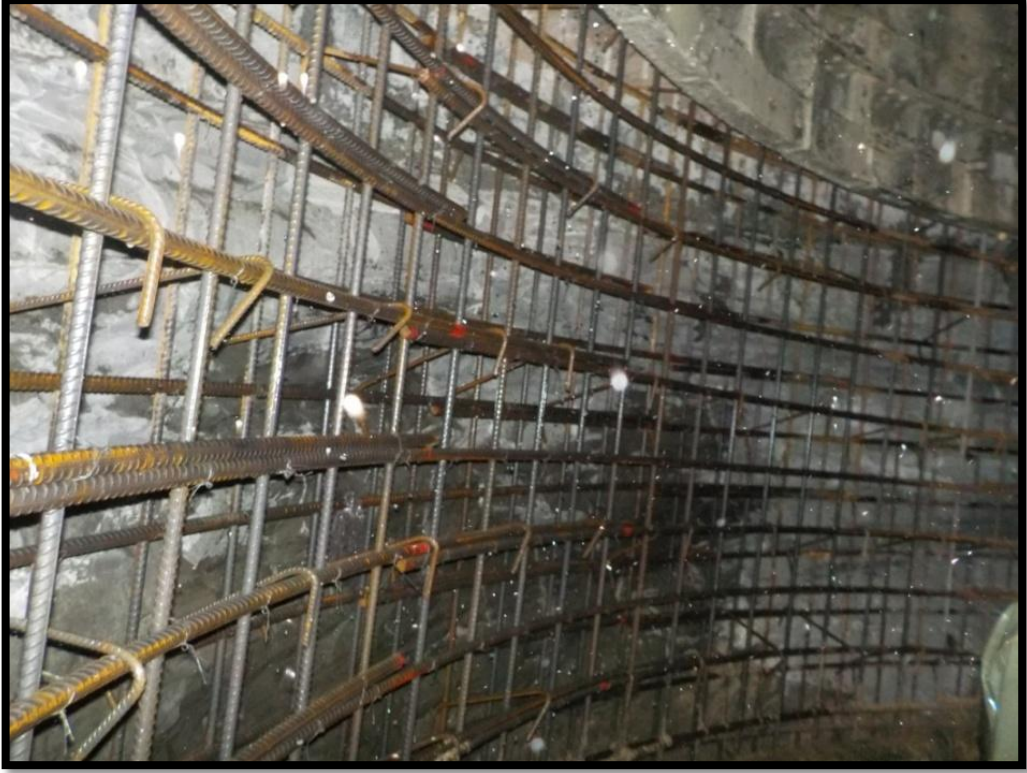
Şekil 4.17. Demir donatı ve kalıp beton
