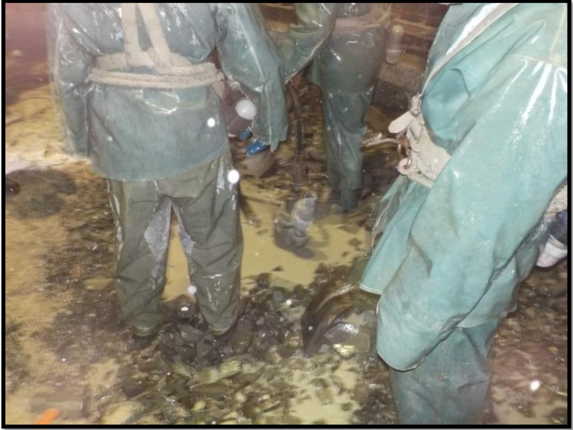
Şekil 4.24. Tabanda 11 kw pompa ile su drenajı
