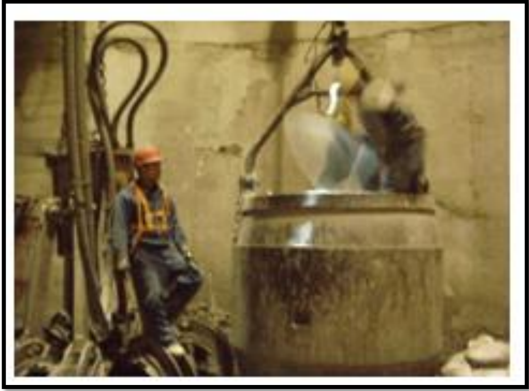
Şekil 4.22. Tahkimat malzemesi ve personel nakliyesi kova ile yapım işlemi
