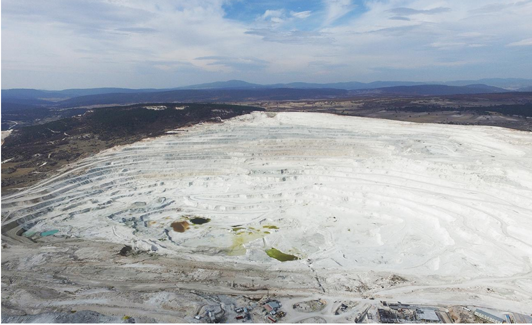
Resim 2.1 Kırka Bor İşletme Müdürlüğü sahası.
