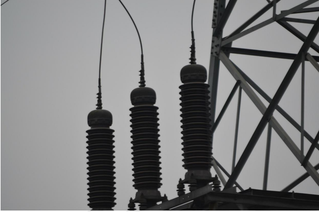
Şekil 2.6. Yüksek gerilim hatlarında kullanılan izolatörler
