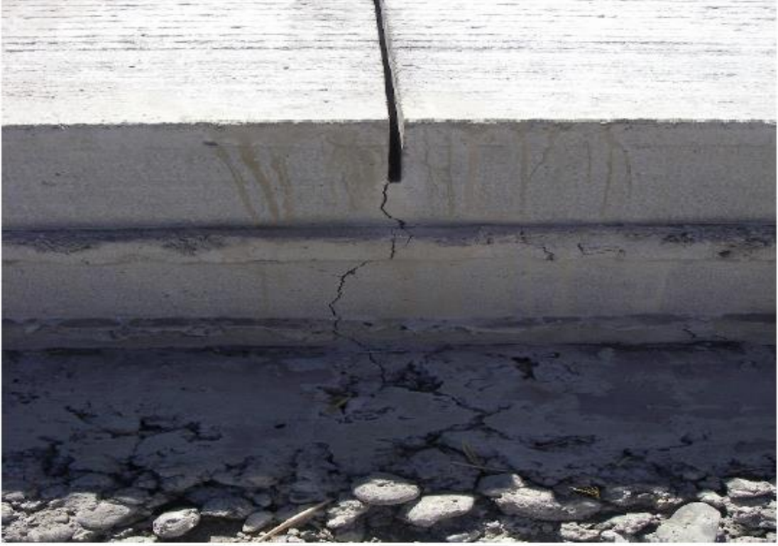
Şekil 2.18. Başarız derz kesimlerine bağlı oluşan çatlamlar [72]
