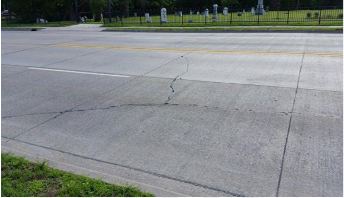
Şekil 2.17. Hacimsel büzölmeye baęlı olarak oluřan atlaklar [71]
