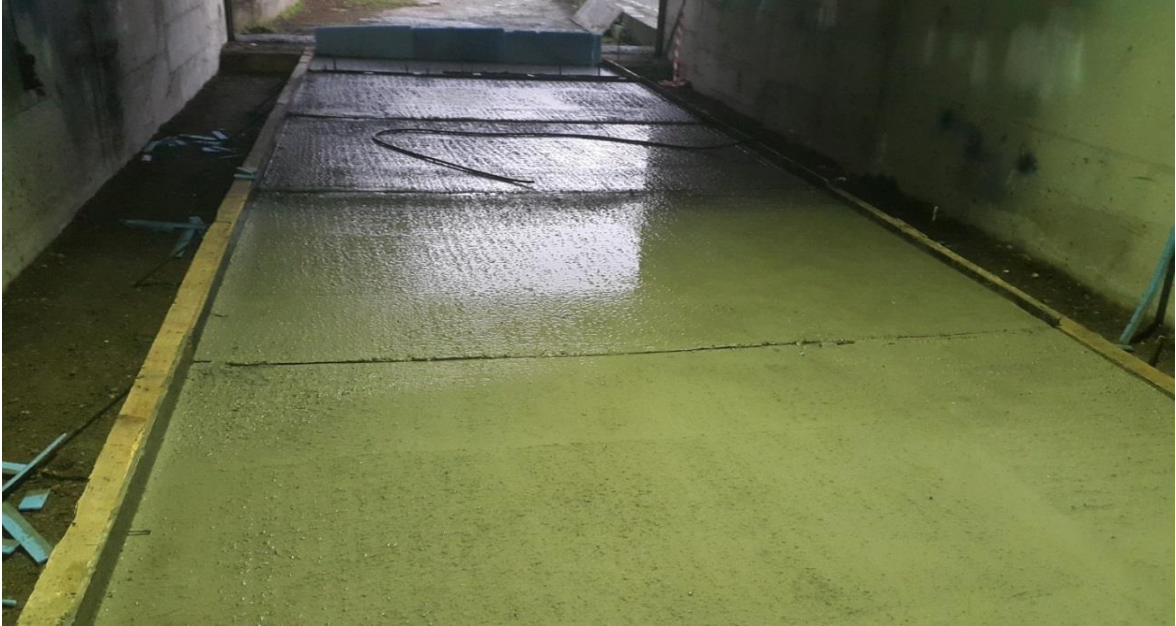
Şekil 3.20. Beton yüzeyinini suyla kürlenmesi
