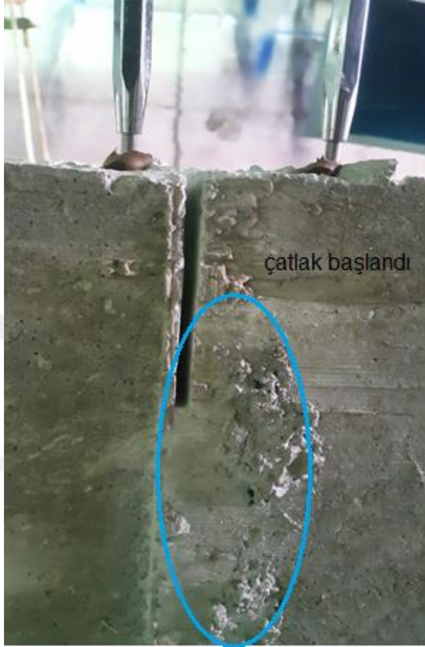
Şekil 4.73. 50.000 yükleme uygulanmasından sonrası çatlak açıklığının gelişimi
