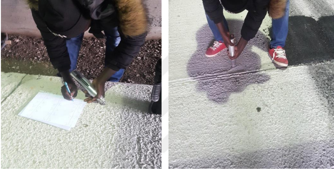
Şekil 4.89. Beton mukavemetinin çekiç cihazıyla ölçülmesi
