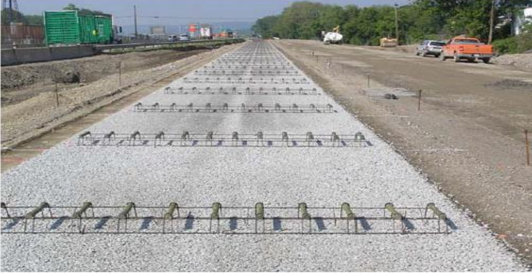
Şekil 1.6. Kayma donatısını kesitin ortasında tutmaya çalışan sepet düzeneği [17]
