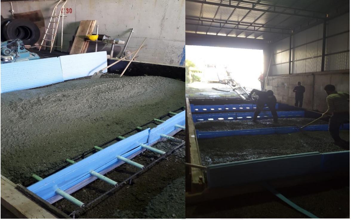
Şekil 3.19. Derz donatıları ve beton döküm işlemi
