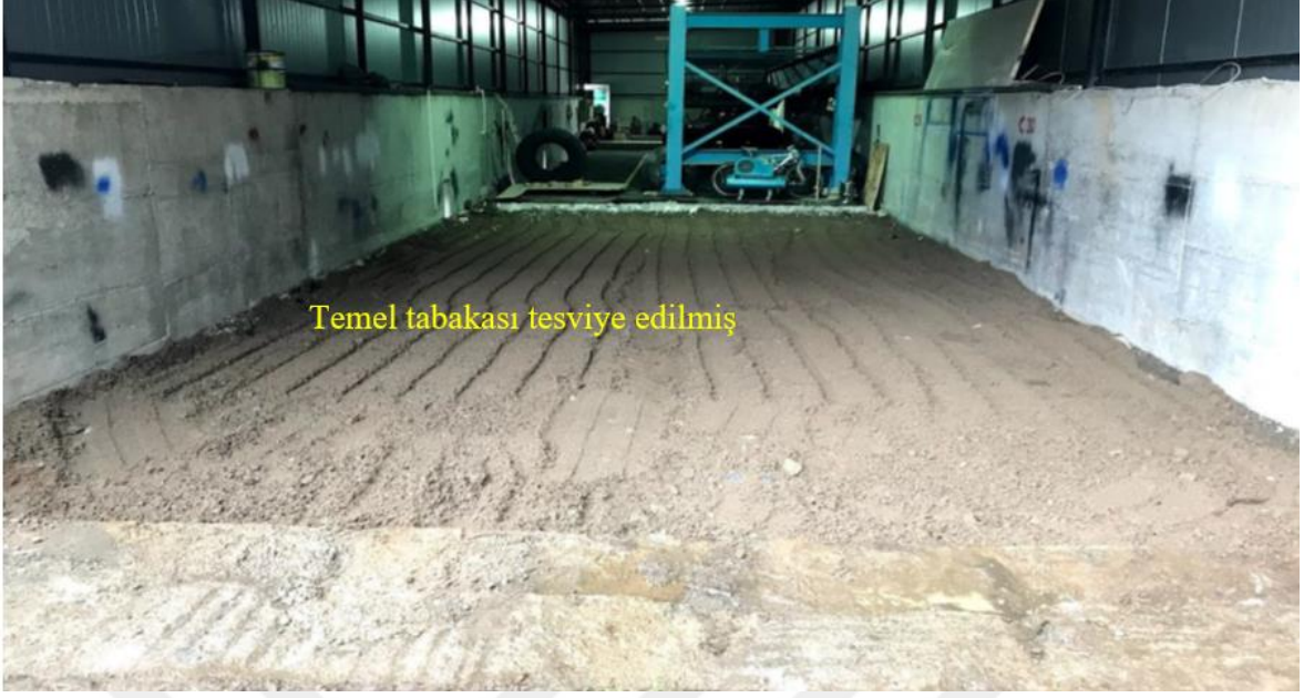
Şekil 3.16. Beton dökümü öncesi temel tabakası zemini
