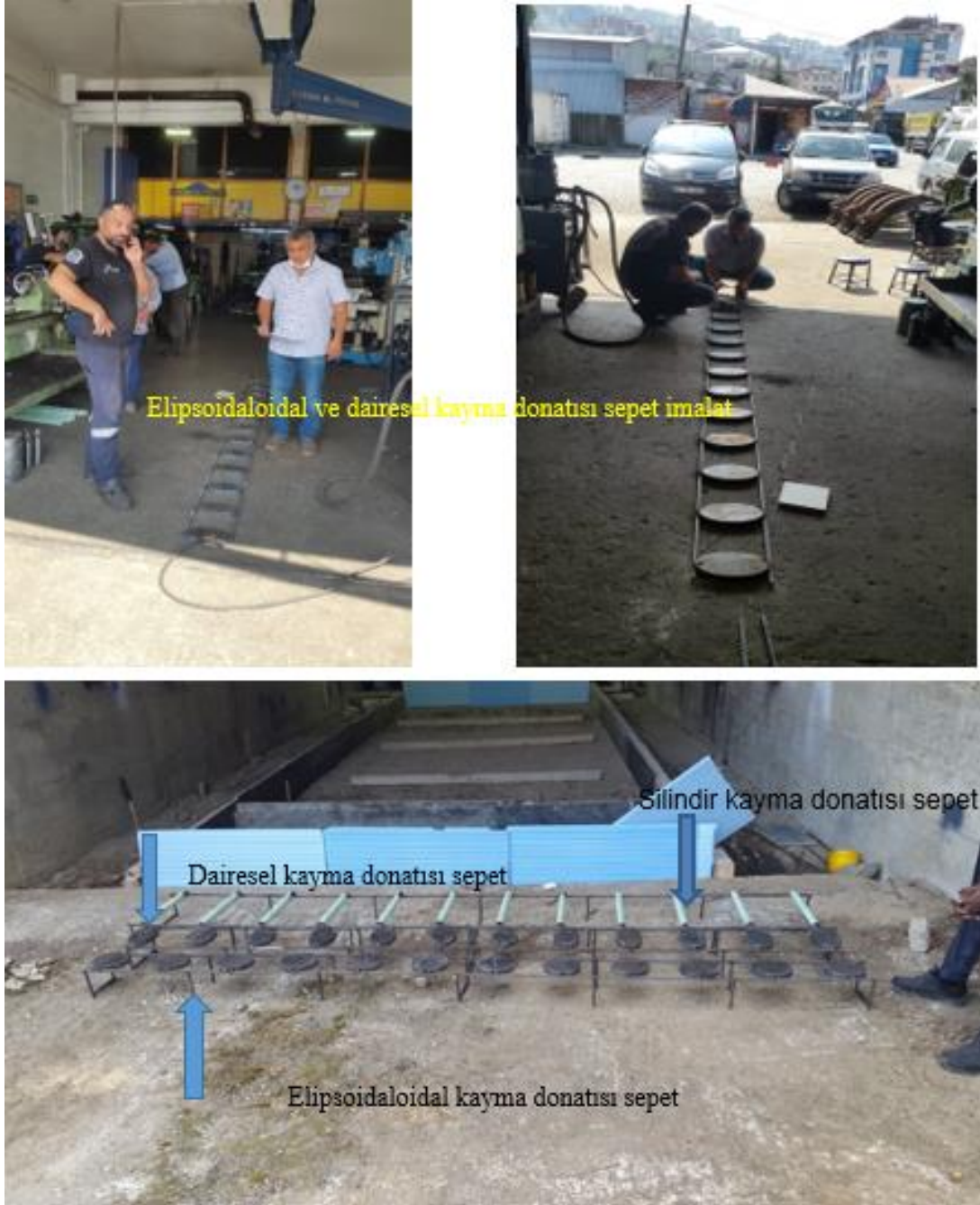
Şekil 3.14. Kayma donatıların sepette yerleştirilmesi
