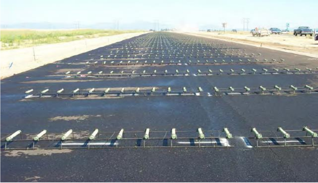
Şekil 1.7. Asfalt yol üzerine yerleştirilen epoksi kaplamalı silindir kayma donatıları [17]
