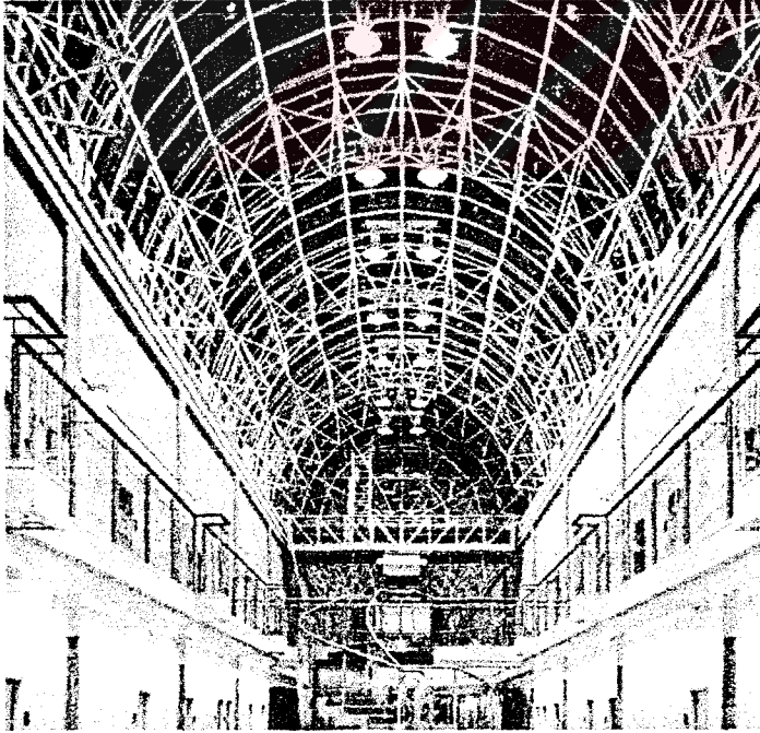
Resim.II-9: Çift Katlı Çember Kesitli Tonz Çatılı Uzay Kafes Sistem.
