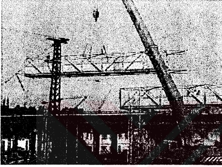
Resim. II-34: İlk Sıranın Yerleştirilmesi.
