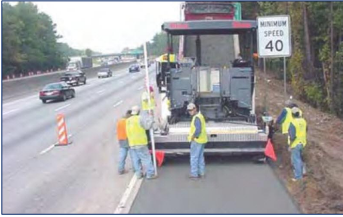
Resim 1.1. SSB banket uygulaması, Atlanta, GA (Harrington ve diğerleri, 2010)
