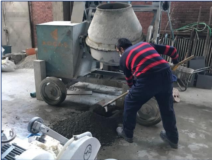
Resim 4.3. SSB'nin döküm yerinde harmanlanarak homojen hale getirilmesi
