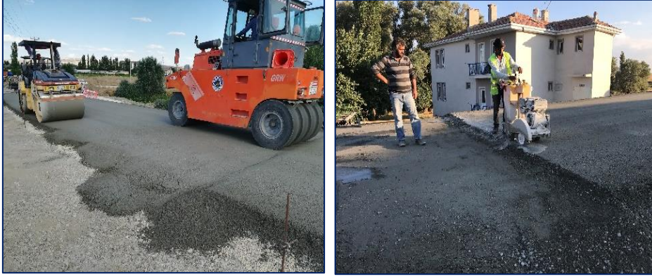
Resim 5.3. Birinci tabaka SSB serimi ve yapım derzi oluşturulması
