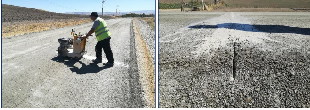
Resim 5.6. Derz kesilmesi işlemi
