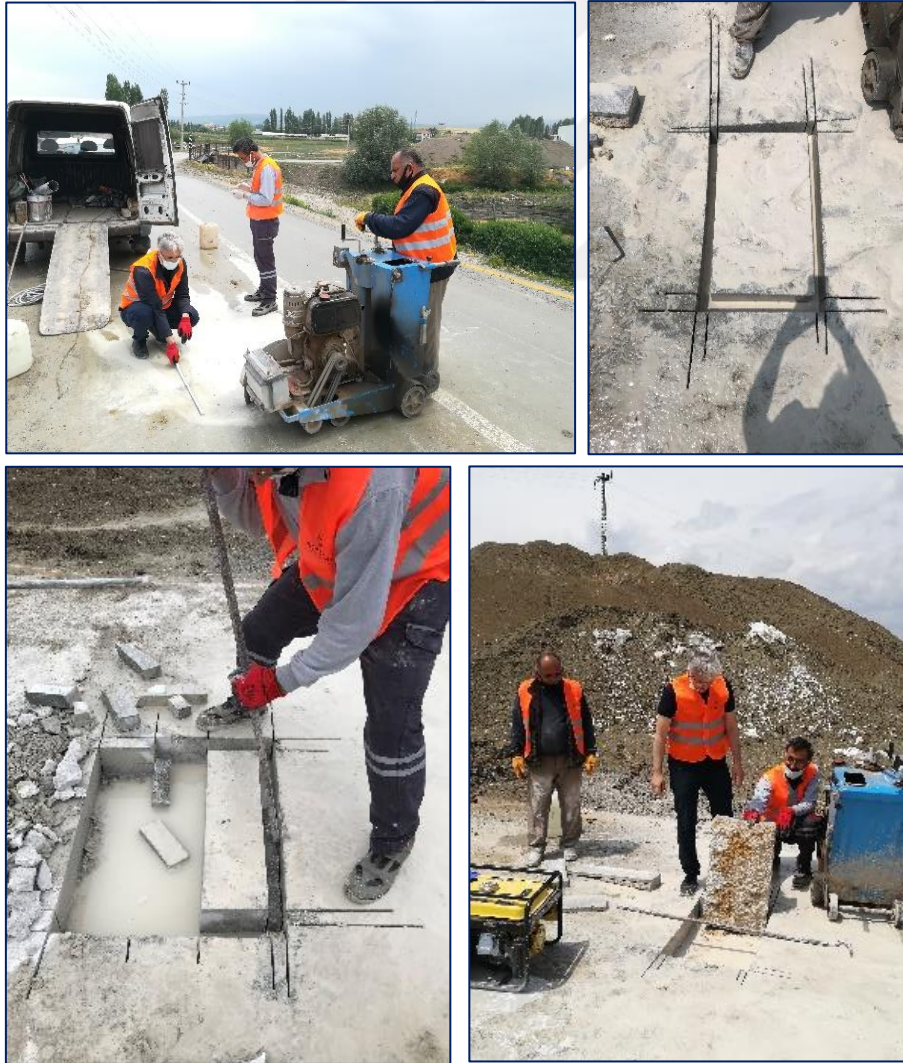
Resim 5.12. Kiriş karot ekipmanları ve kiriş numune alma işlemleri
