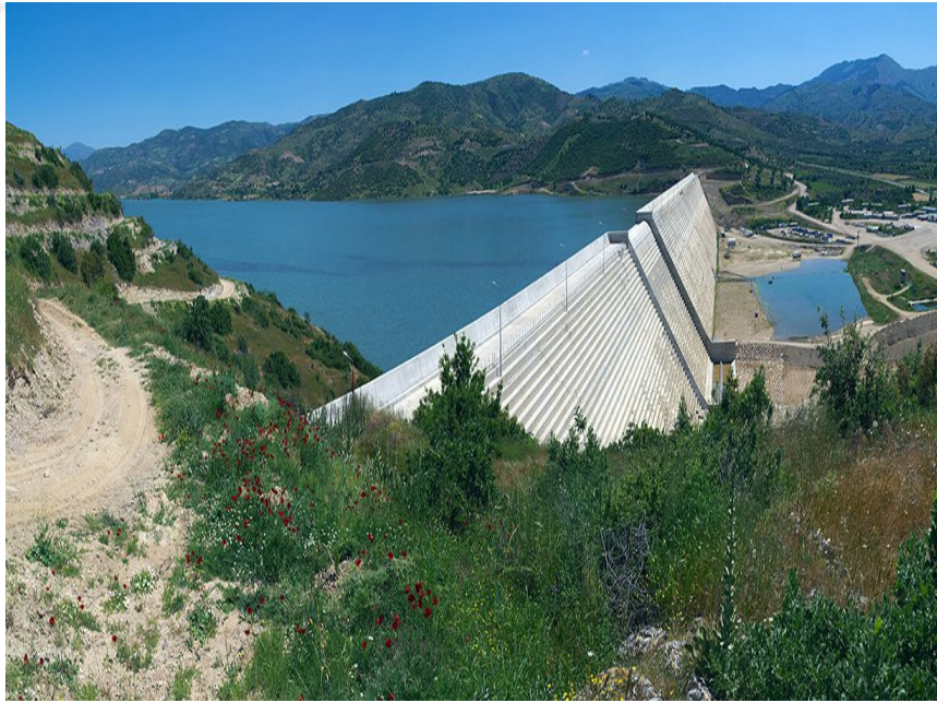
Şekil 3.2. İzmir Beydağ barajı genel görünüm
