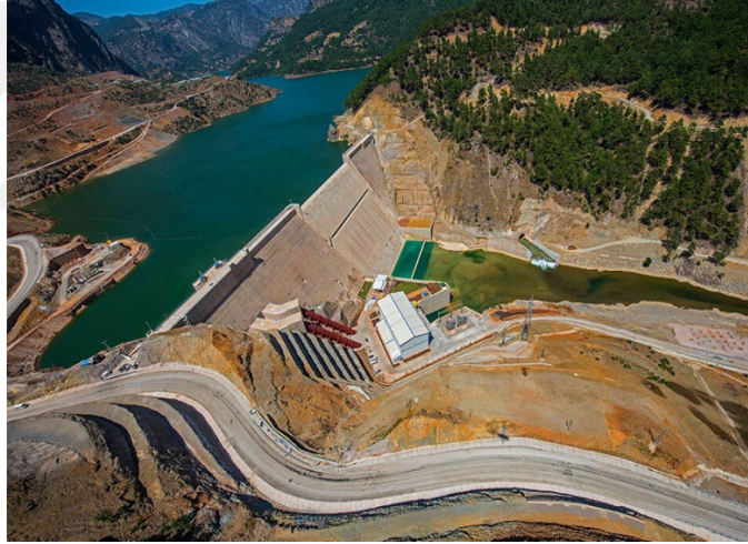
Şekil 3.5. Adana Köprü barajı genel görünüm
