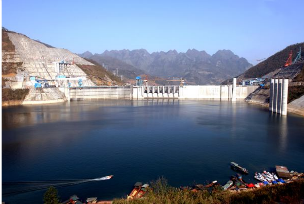
Şekil 3.11. Çin Linton barajı genel görünüm
