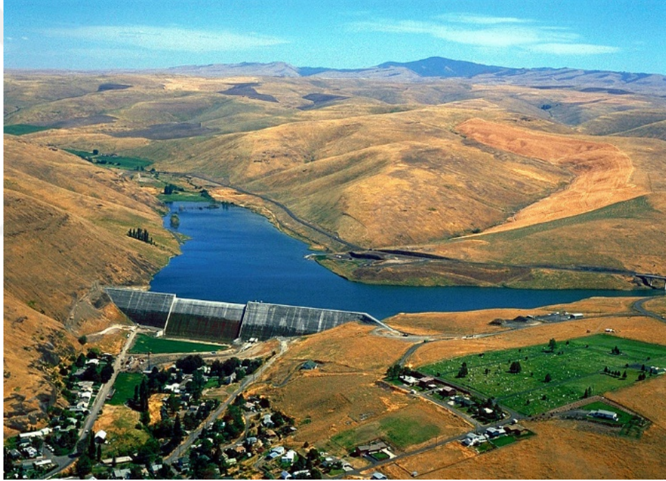
Şekil 3.10. ABD Willow Creek barajı genel görünüm
