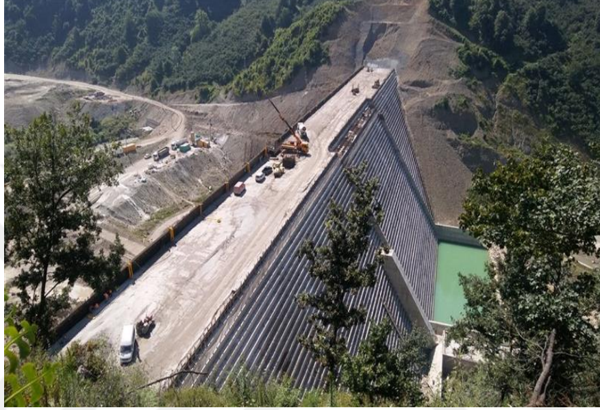
Şekil 3.9. Sakarya Ballıkaya barajı genel görünüm
