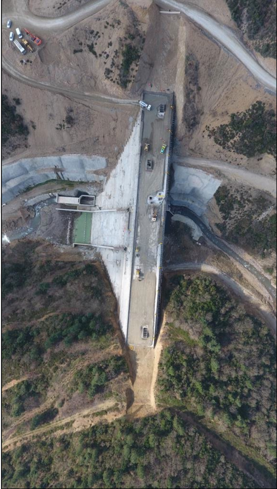
Şekil 5.3. İhsaniye barajı inşa görüntüsü
