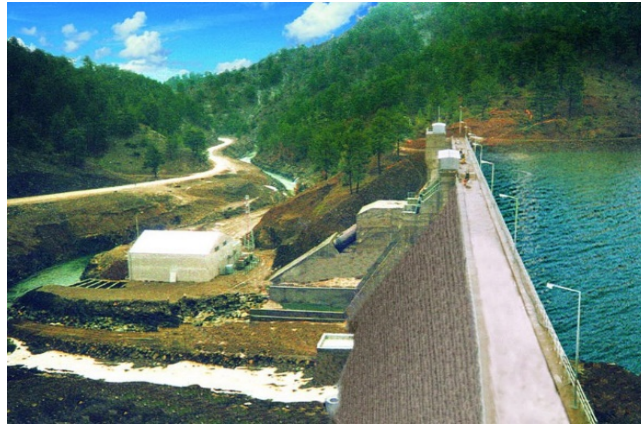
Şekil 3.7. Kahramanmaraş Suçati barajı
