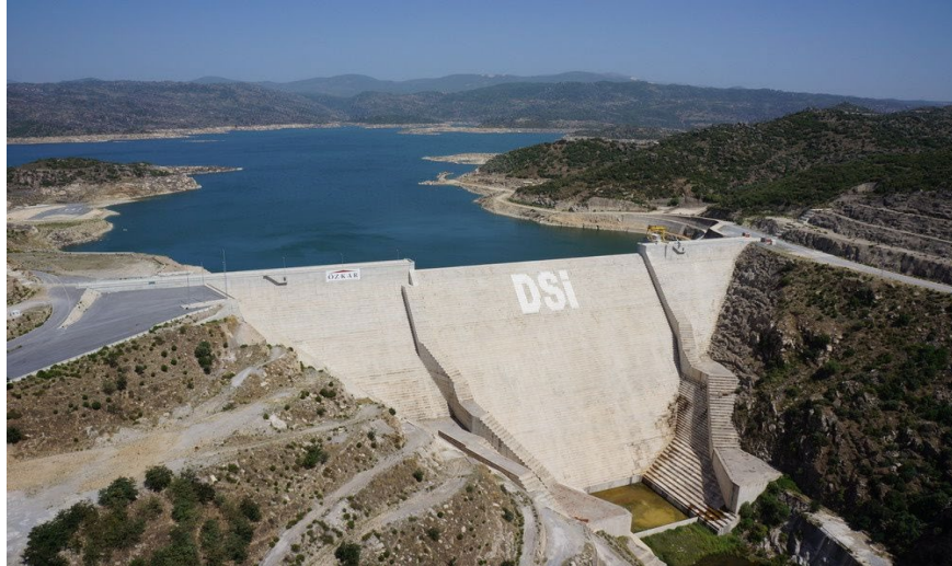
Şekil 3.4. Aydın Çine barajı genel görünüm
