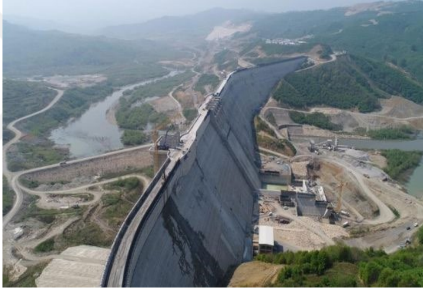
Şekil 3.8. Sakarya Melen barajı genel görünüm
