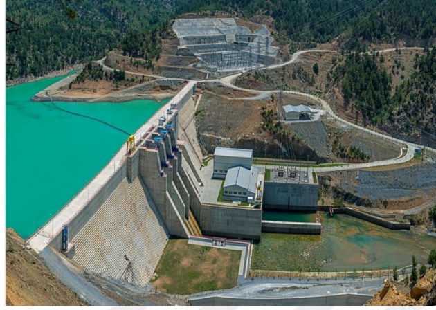
Şekil 3.6. Adana Menge barajı genel görünüm
