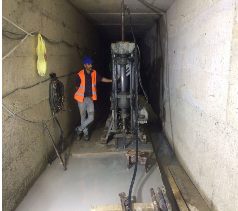
Şekil 8.1. Düz galeride enjeksiyon yapılması
