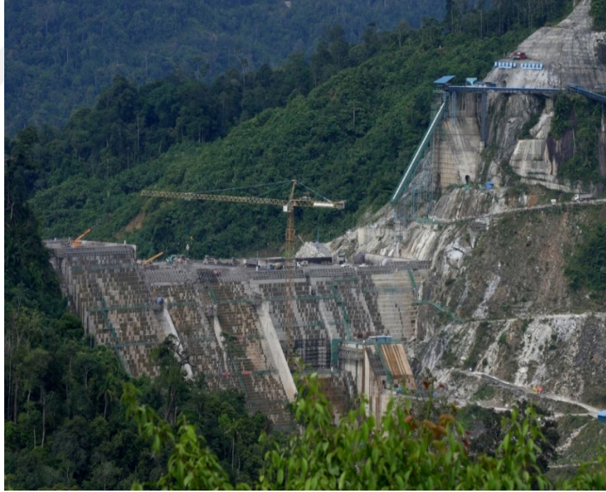
Şekil 3.15. Malezya-Murum barajı genel görünüm
