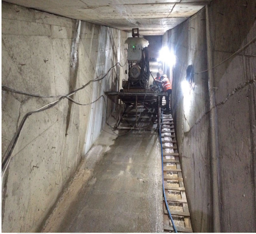
Şekil 8.2. Eğimli galeride enjeksiyon yapılması
