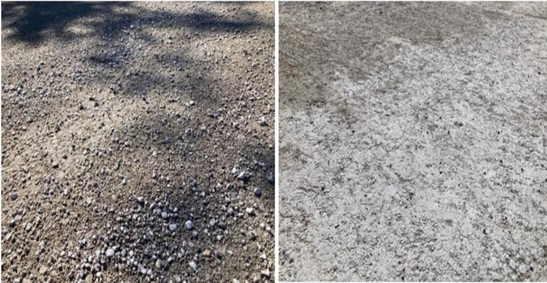
Şekil 32. Sırasıyla düşük kalite ve yüksek kaliteye sahip kaplama yüzeyleri
