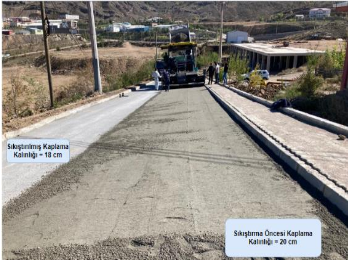
Şekil 27. Finişer ile beton malzemenin serilmesi
