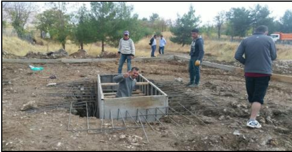
Şekil 4.4. SK-1 kuyusuna ait çalışmalar (DSİ,2017).
