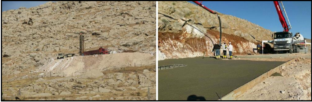
Şekil 4.8. SK-2 kuyusuna ait çalışmalar (DSİ,2017)
