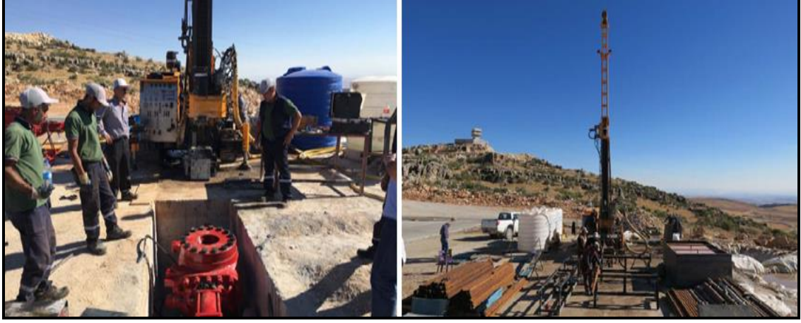
Şekil 4.24. SK-6 kuyusuna ait çalışmalar (DSİ,2017)
