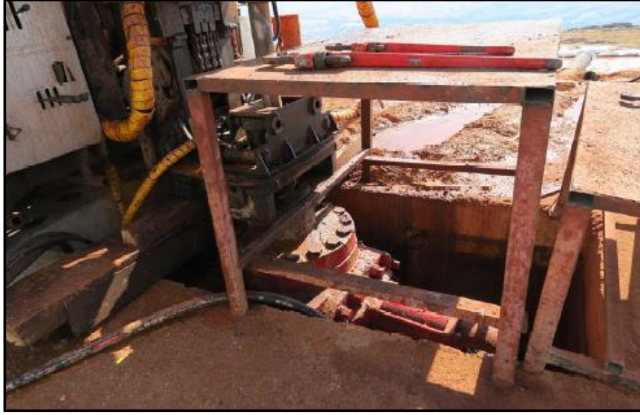
Şekil 4.12. SK-3 kuyusuna ait çalışmalar (DSİ,2017)
