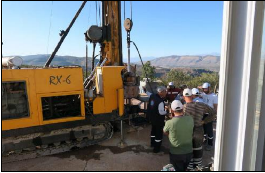
Şekil 4.33. SK-8 kuyusuna ait çalışmalar (DSİ,2017)
