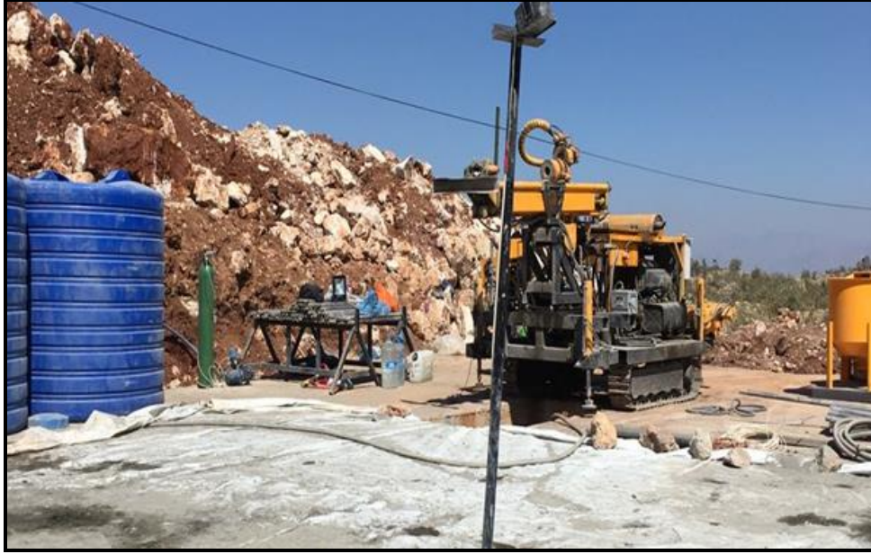
Şekil 4.28. SK-7 kuyusuna ait çalışmalar (DSİ,2017)
