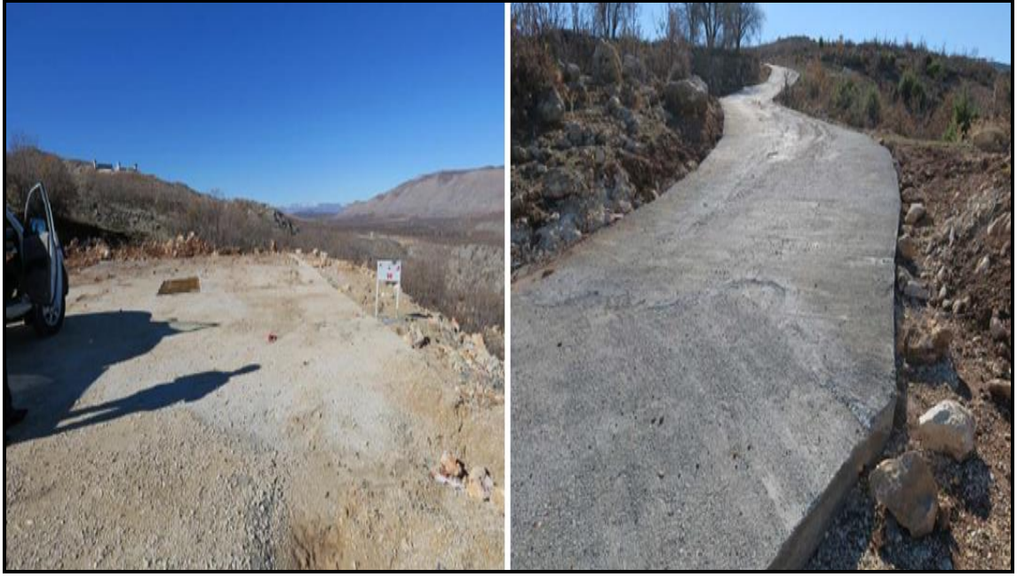
Şekil 4.41. SK-10 kuyusuna ait çalışmalar (DSİ,2017)
