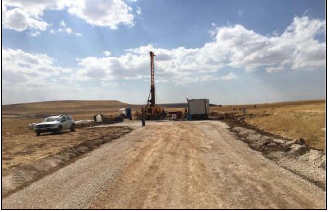
Şekil 4.20. SK-5 kuyusuna ait çalışmalar (DSİ,2017)
