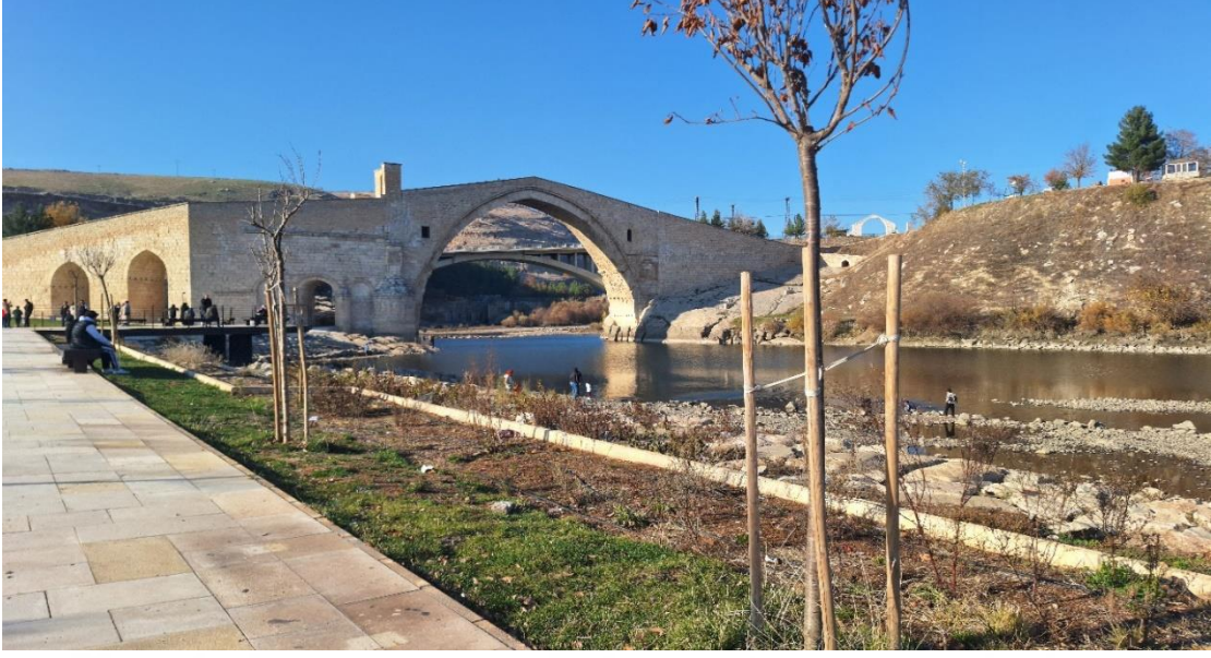
Fotoğraf 2: Malabadi Köprüsü
