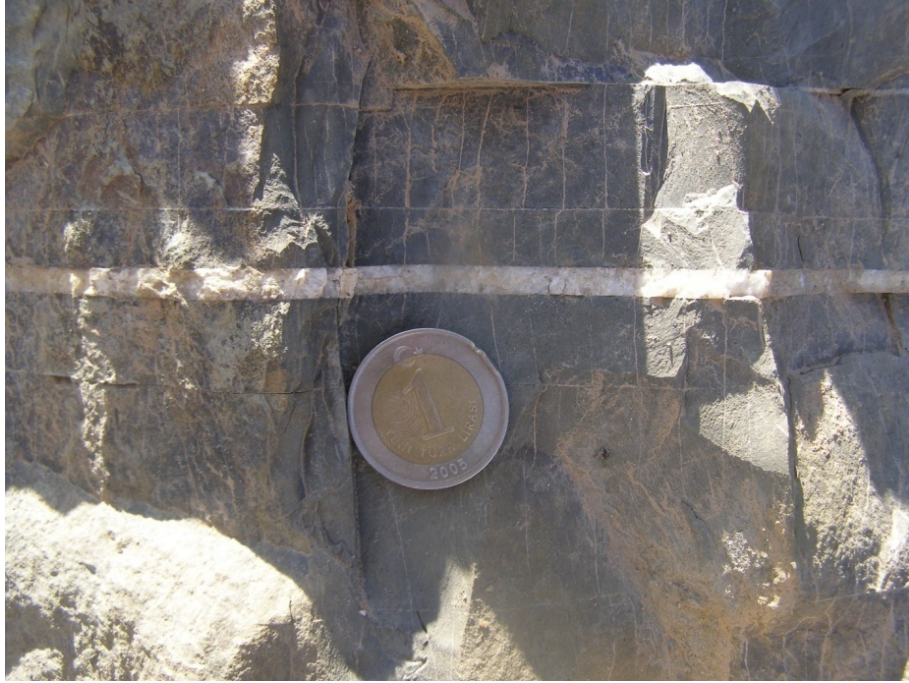
Şekil 4.8. Silttaş eklemlerinde gözlenen kalsit dolgu.
