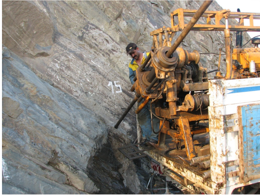
Şekil 4.9. Silttaşlarında 40°'lik jeoteknik amaçlı sondajın yapılması (Bakış yönü KD)
