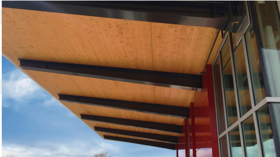
Şekil 1.2. Gövdesi daralan konsol kiriş uygulaması (Anonim)
