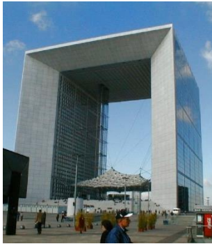
Johann Ottovon Spreckelsen, Grande Arche de la Defence
