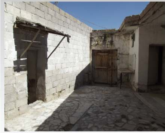
Şekil 65.A. Oya Kırçalı Evi Kaynak: Kabaltı Mimarlık, 2015
