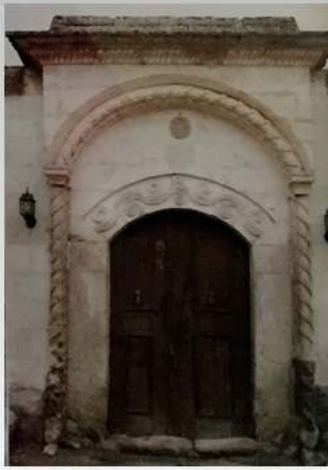
Şekil 95.A. Kapı kemerindeki Süsleme Kaynak: Demirkol Arşivi, 2015
