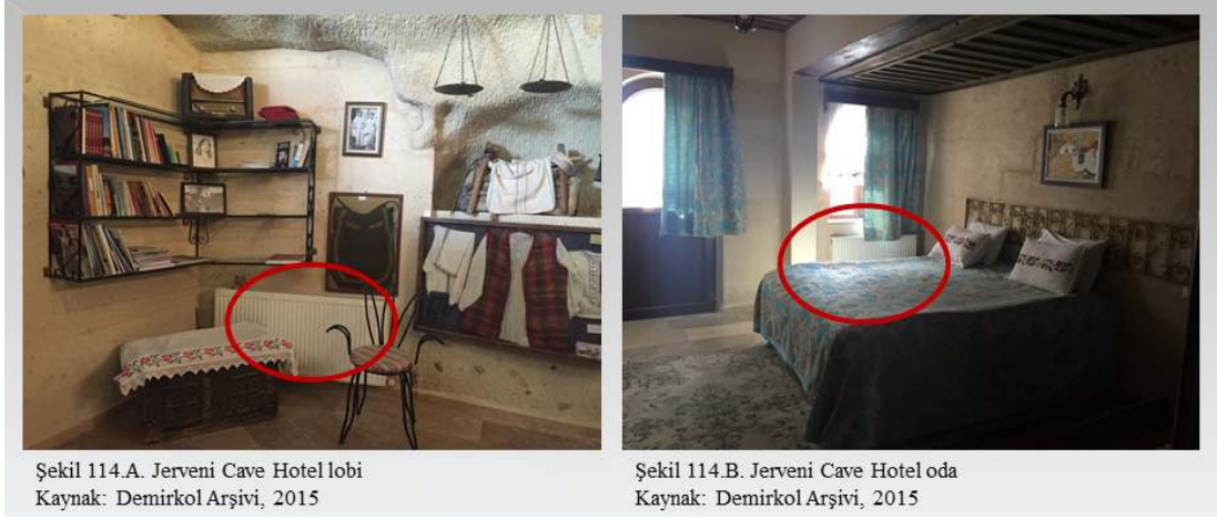
ŞEKİL 114. Jerveni Cave Hotel kalorifer noktaları
