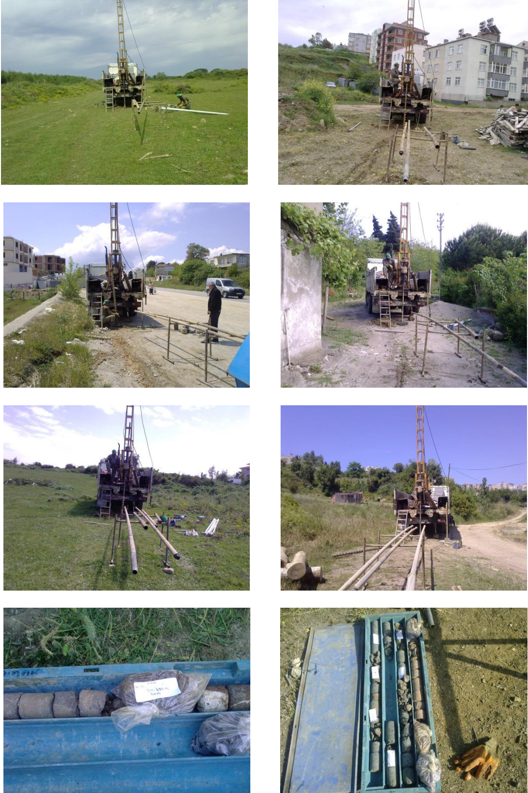
Şekil 7. Sinop merkez ilçesinde yapılan sondaj çalışmaları ve zeminlerden alınan karot örneklerine ait görüntüler (Sinop Belediyesi, 2010).
