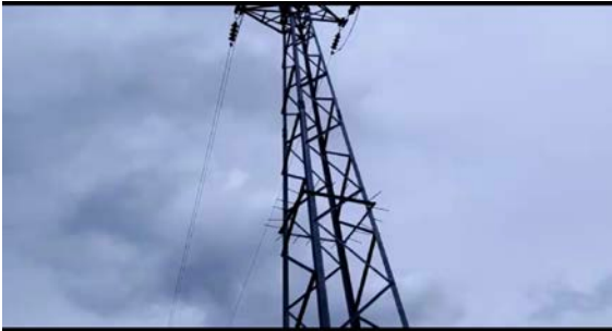
Şekil 3.7 Numune alınan bölge
