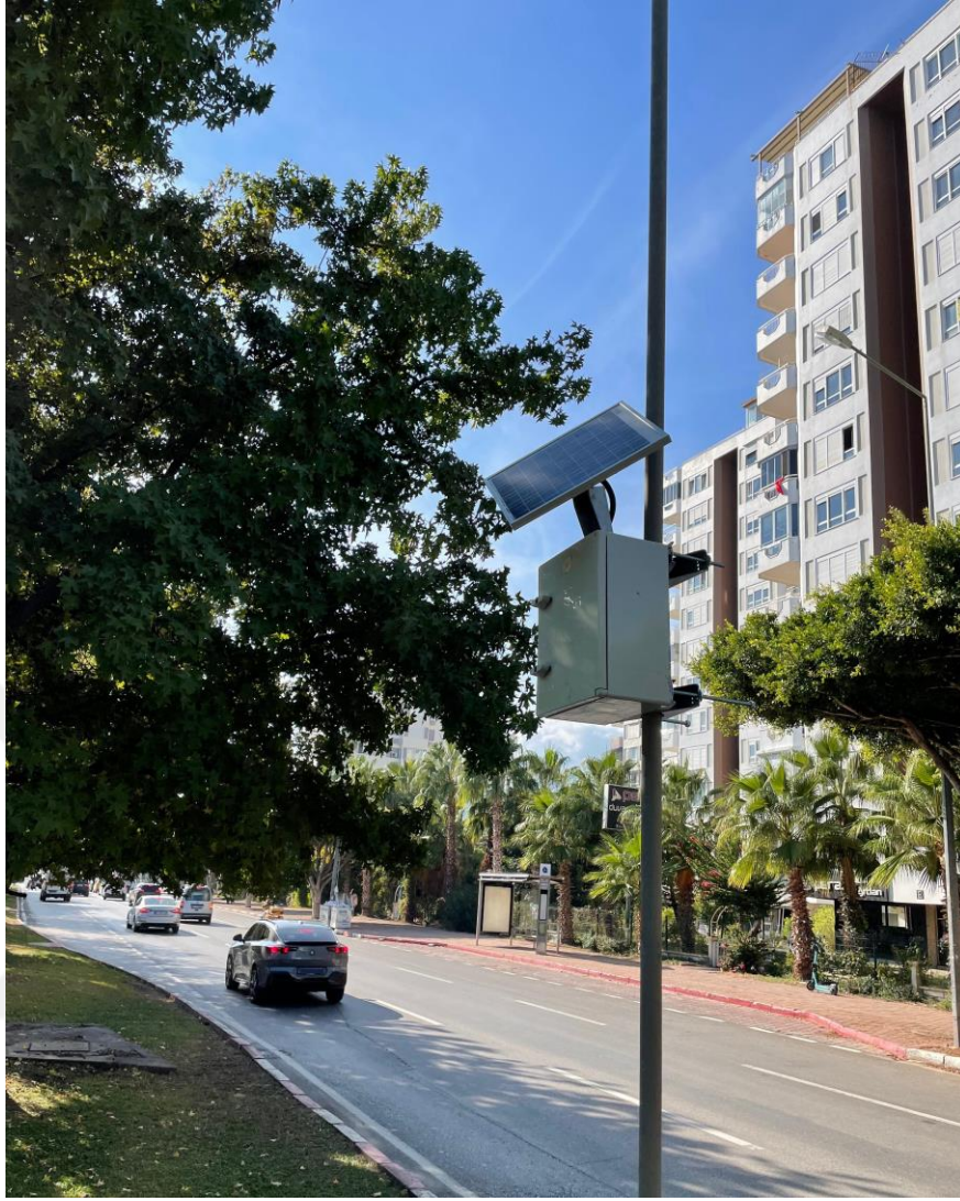
Şekil 4.5. Bluetooth trafik analiz sensörü saha montajı
