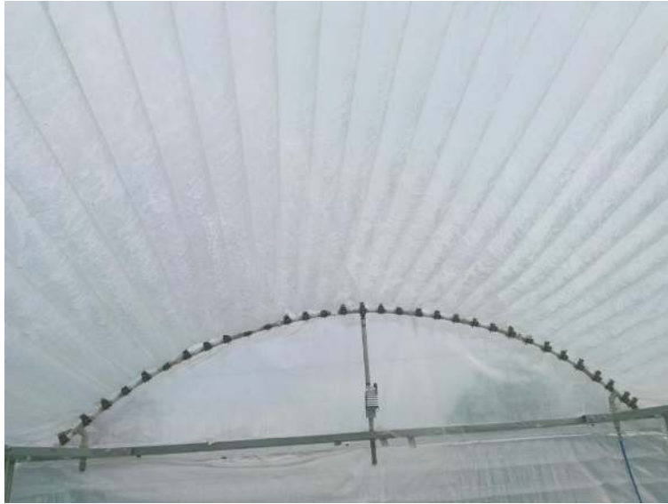
Şekil 3.21. Montajı tamamlanmış çatı örtüsü
