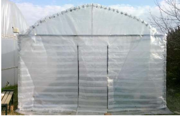
Şekil 3.28. İskelet ve örtü montajı tamamlanan sera ön görünümü
