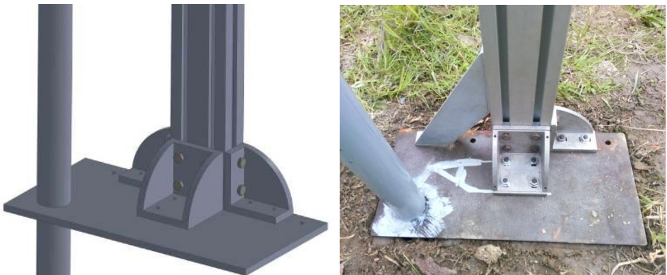
Şekil 3.14. Sigma profil zemin bağlantısı
