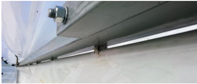
Şekil 3.18. Çatı çerçevesi - yan örtü bağlantısı
