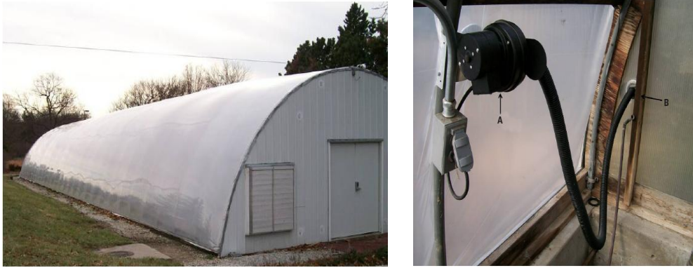
Şekil 1.4. Şişme seraların şişirilmesinde kullanılan fan sistemi
