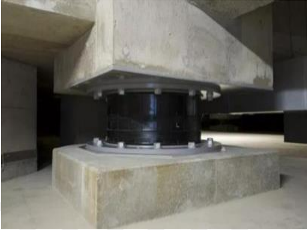
Şekil 11. Kauçuk izolatörü (HDRB) (URL- 3)
