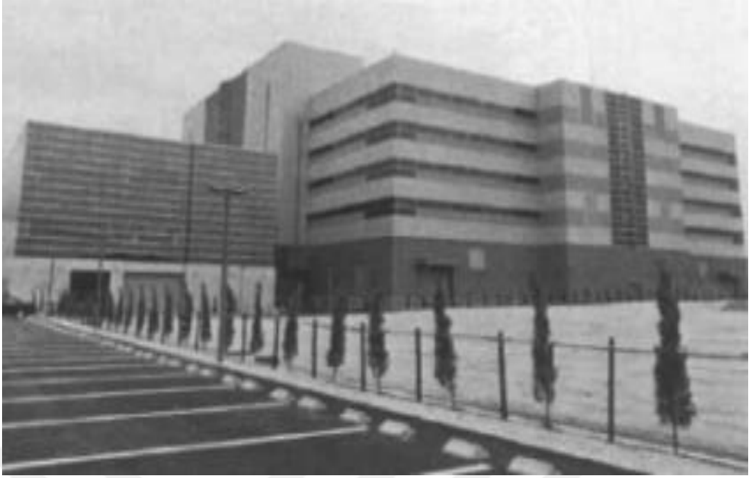
Şekil 28. Posta ve telekomünikasyon bakanlığı bilgisayar merkezi
