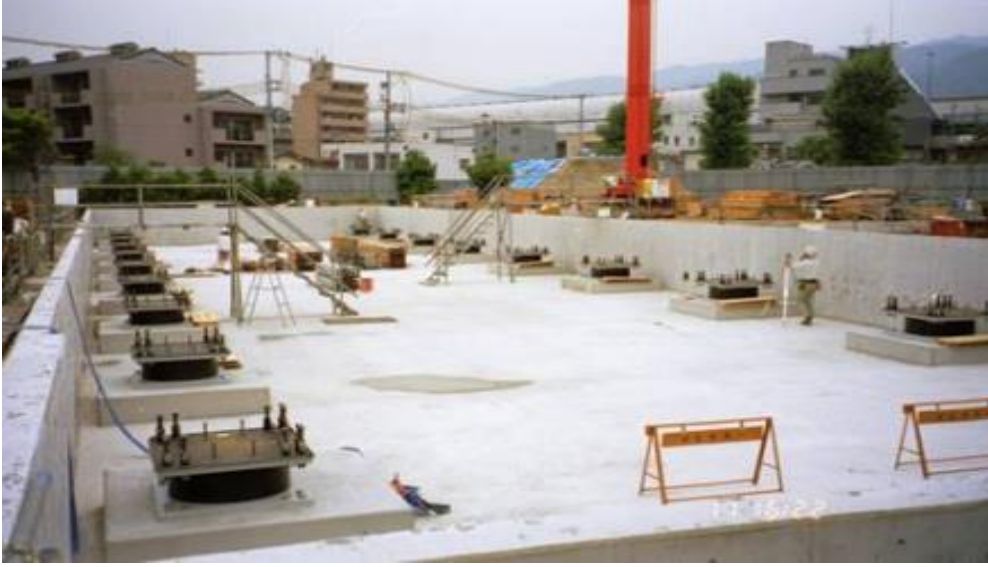
Şekil 10. Temel üst kotunda yerleştirilen izolatörler (URL-2)
