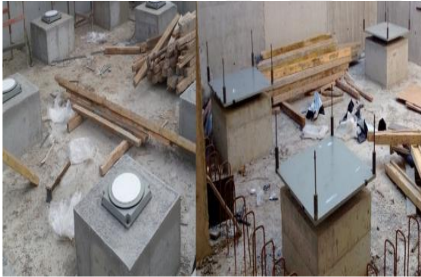
Şekil 13. Kayıcı mesnetli sistemi
