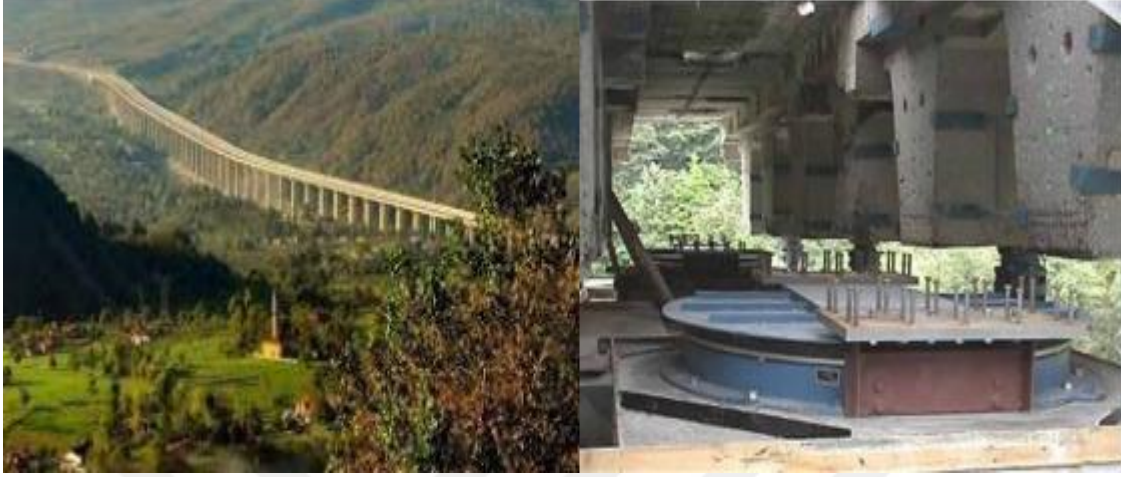
Şekil 2.5. Bolu viyadüğü sürtünmeli sarkaç izolatör uygulaması ( Kaynak: Rousis vd., 2003)
