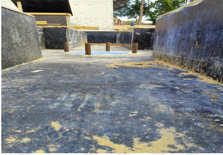
Şekil 4.11. Yalıtım katı üst temel imalatı
