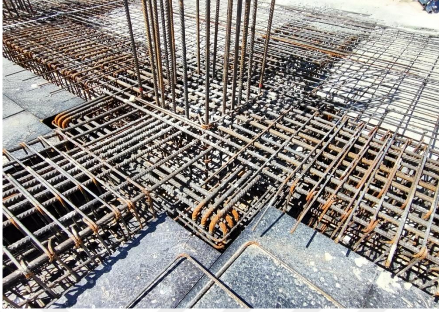
Şekil 4.13. Yalıtım katı üst imalatı
