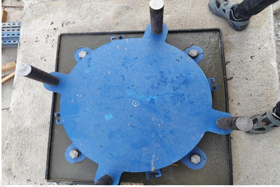
Şekil 4.5. Grout harcının kalıba pompa ile kalıpkaki boşluktan basılması
