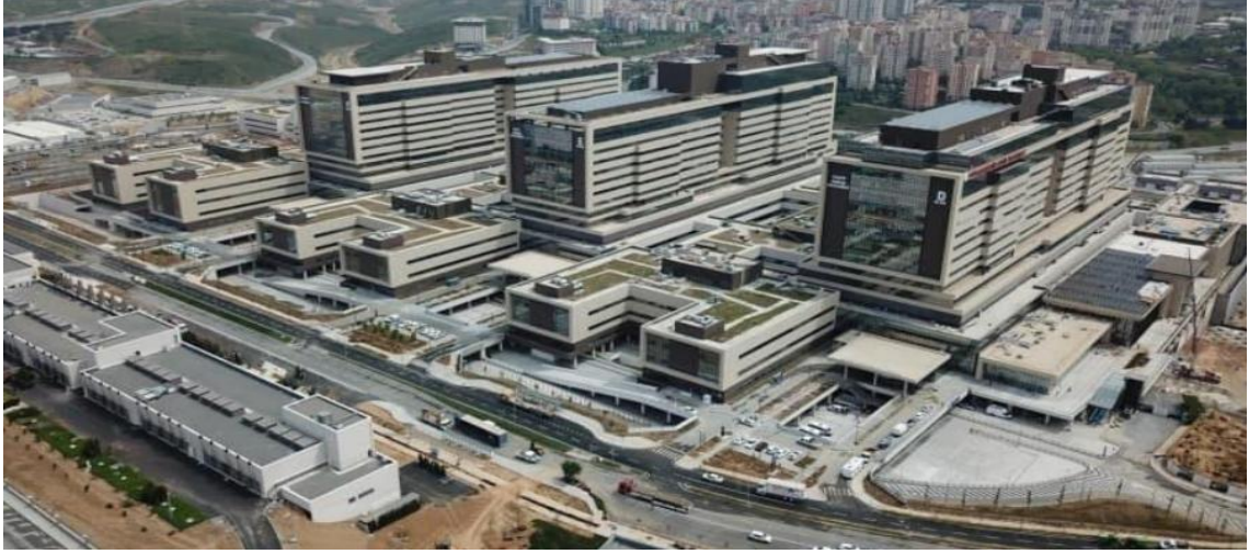
Şekil 2.8. İstanbul Başakşehir Çam ve Sakura Şehir Hastanesi (2068 İzolatör)
