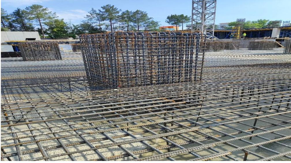
Şekil 4.1. Yalıtım birimi alt yapı kolon-temel
