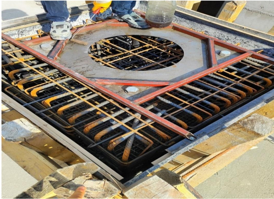
Şekil 4.2. Yalıtım birimi platform montajı
