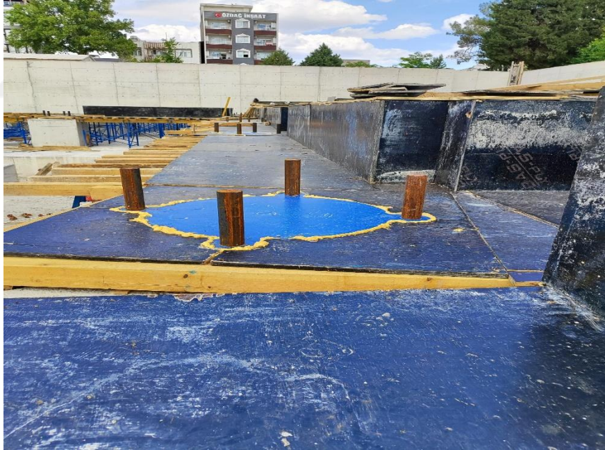
Şekil 4.10. Yalıtım katı üst temel imalatı
