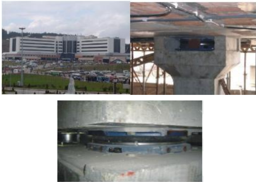
Şekil 2.6. Kocaeli hastanesi sismik izolatör uygulaması
