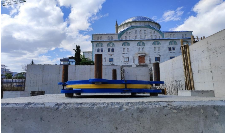
Şekil 4.3. Yalıtım birimi alt kolona montajı
