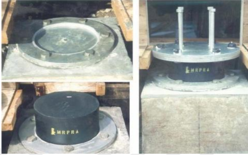
Şekil 2.11. Düşük sönümlü kauçuk mesnet uygulama aşamaları (Kaynak: Yücesoy, 2005)
