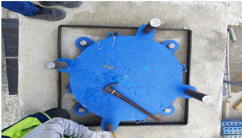
Şekil 4.4. Yalıtım birimi grout harcı için kalıba alınması
