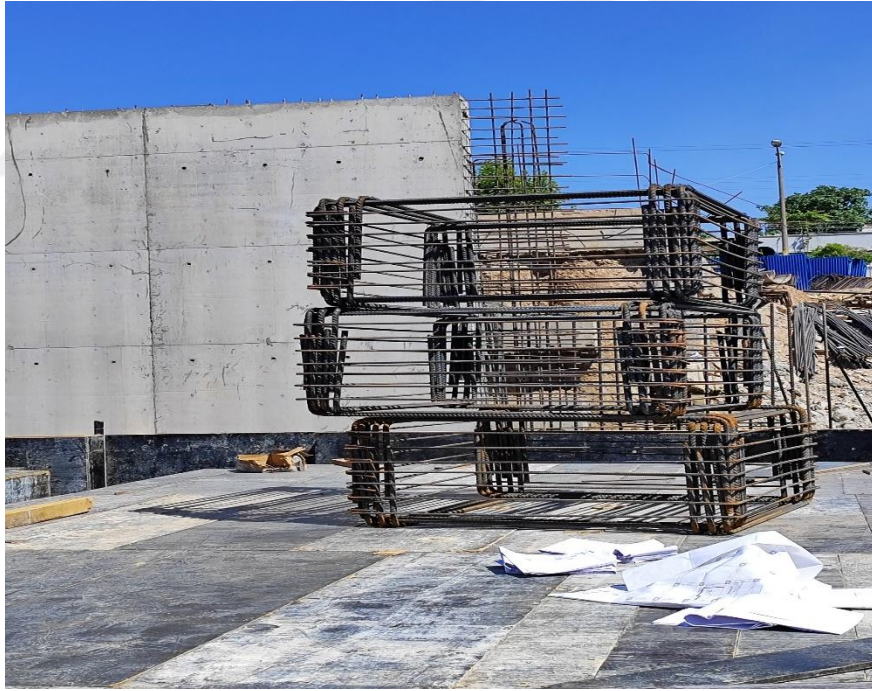
Şekil 4.12. Yalıtım katı üst imalatı-kolon başlığı
