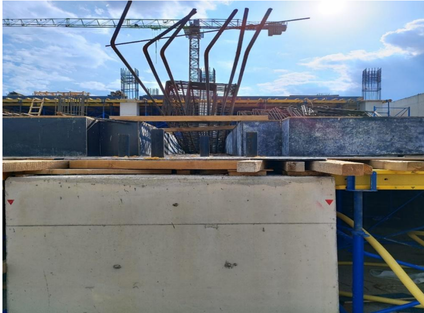
Şekil 4.8. Yalıtım katı üst temel imalatı
