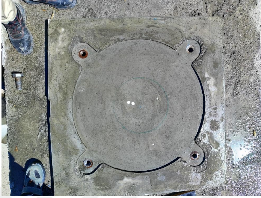
Şekil 4.7. İzolatör birimi boşluk tespiti için boşluklara alçı ile doldurulması
