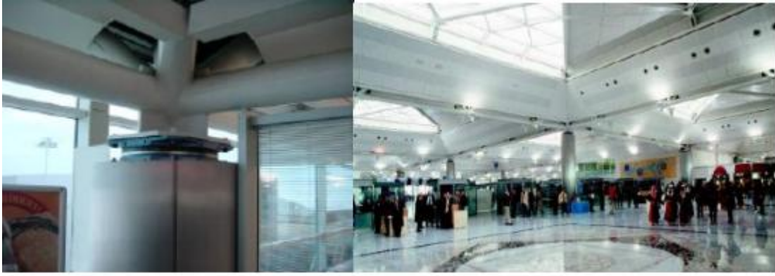
Şekil 2.7. İstanbul Atatürk Havalimanı sarkaç tipi izolatör uygulaması (Kaynak: Constantiinou, Whittaker ve Velivasakis, 2001)
