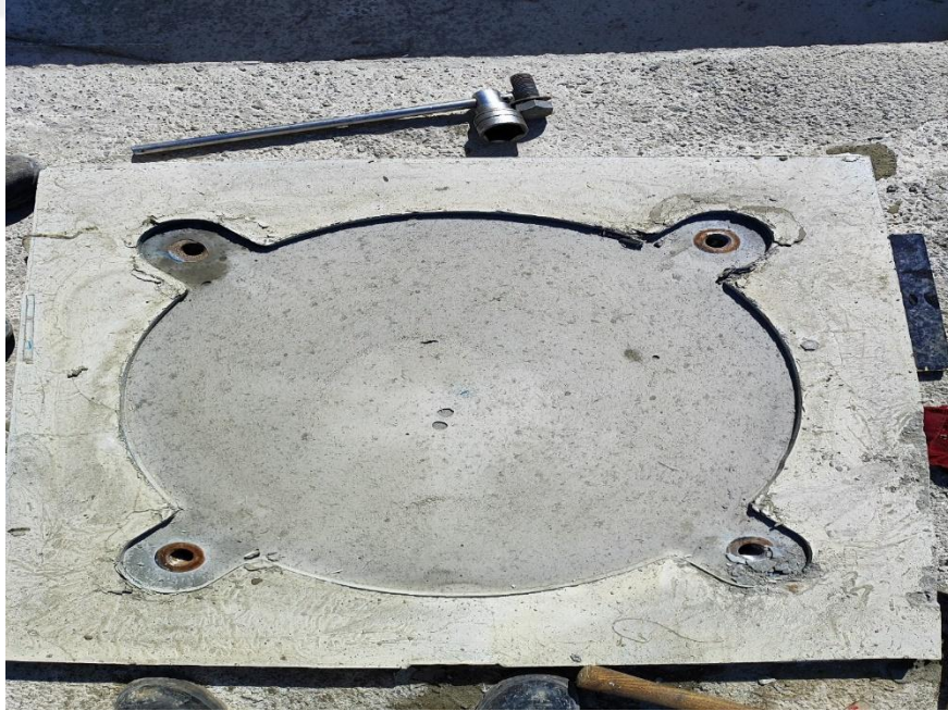
Şekil 4.6. İzolatör birimi demontajı
