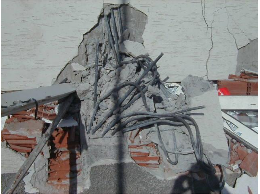
Şekil 5.7 Uygunsuz Granülometri
