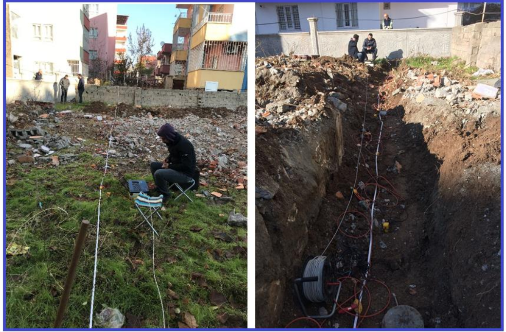
Şekil 4.45. İnceleme alanında yapılan sismik yöntem ölçüm çalışmaları
