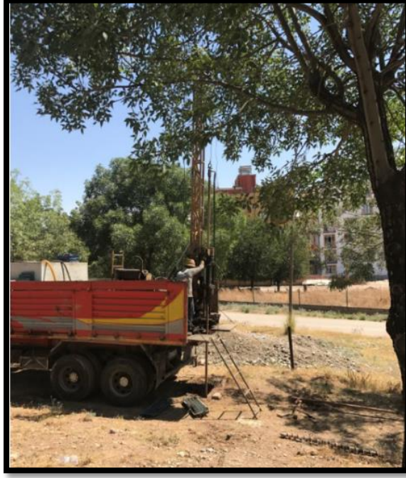
Şekil 4.4. İnceleme alanında yapılan sondaj çalışması
