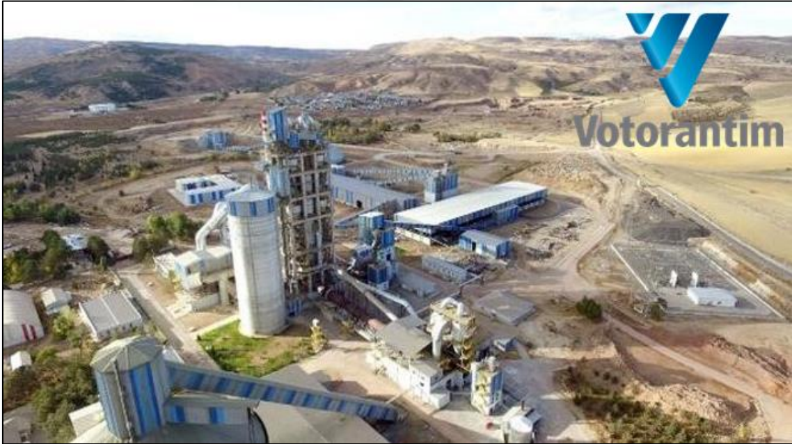
Resim 6.1 Sivas çimento fabrikası genel görünümü (İnt.Kyn. 4).
