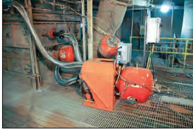
Resim 3.3 Tek hava tankı ile çoklu hava çıkışına sahip hava şoku sistemi (İnt.Kyn. 3).
