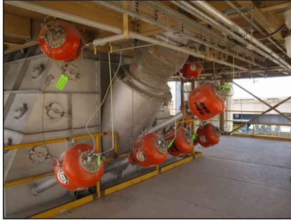
Resim 3.2 Çimento fabrikası ön-ısıtıcı kulesi intikal bölgesi hava şoku uygulaması (İnt.Kyn. 3).
