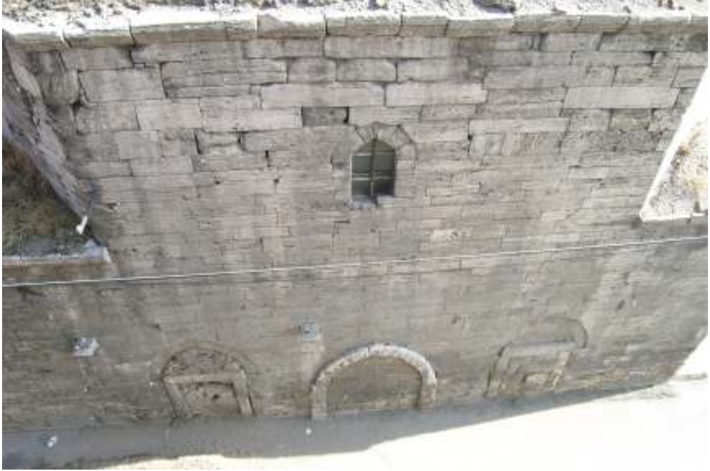
Fotoğraf: 47 Kurşunlu Hamamı, kadınlar kısmı batı cephe
