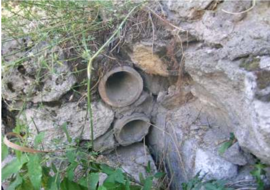
Fotoğraf: 28 Kale Hamamı, duvarların içindeki künkler
