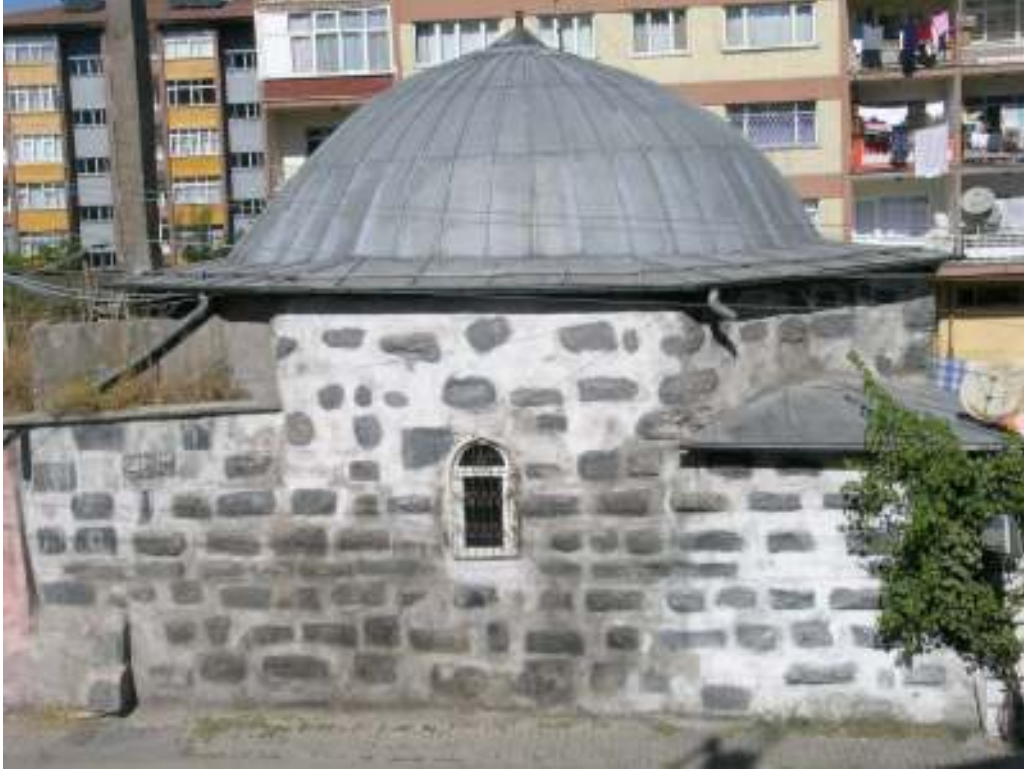
Fotoğraf: 3 Eski Paşa Hamamı, soyunmalık mekânının güneyden görünüşü
