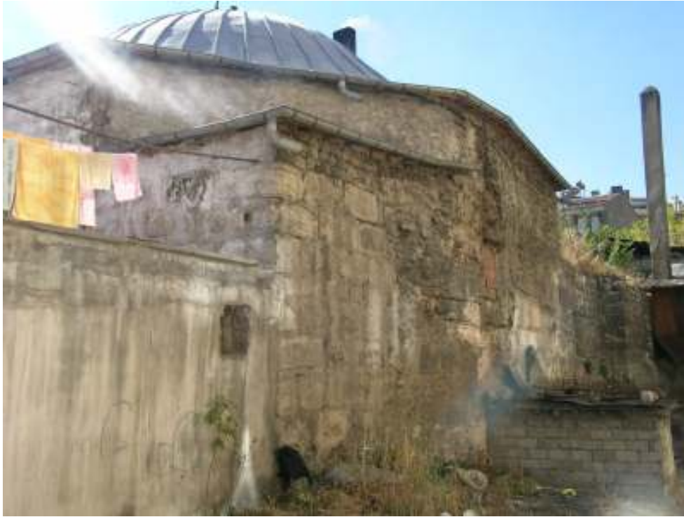
Fotoğraf: 4 Eski Paşa Hamamı, kuzey cephe
