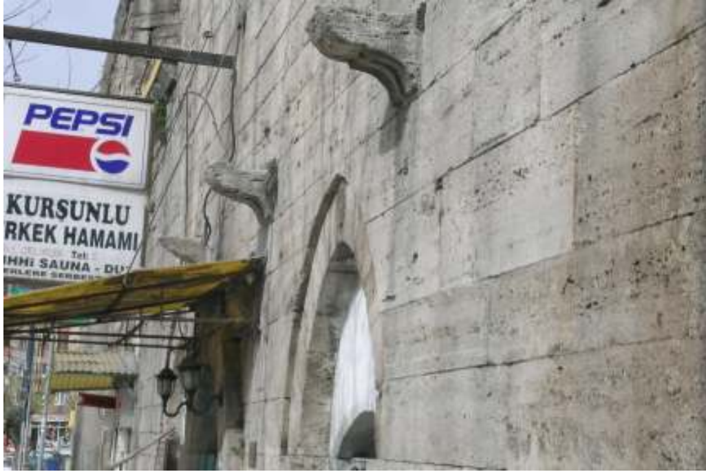
Fotoğraf:43 Kurşunlu Hamamı, erkekler kısmı giriş cephesindeki konsollarar
