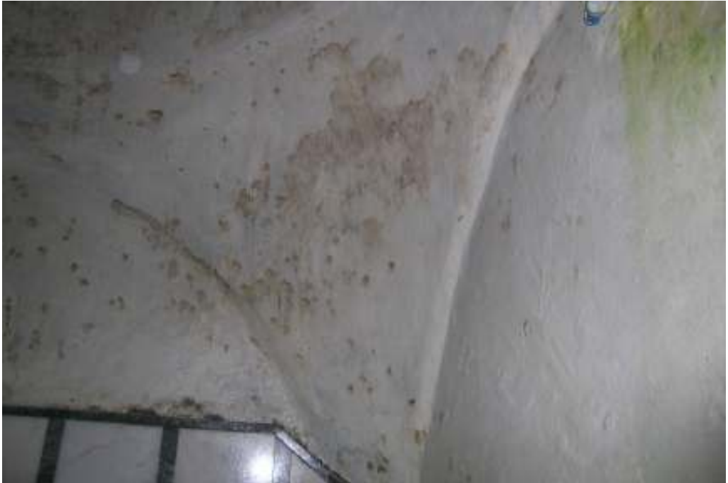
Fotoğraf:126 Meydan Hamamı helasında kubbeye geiş elemanı
