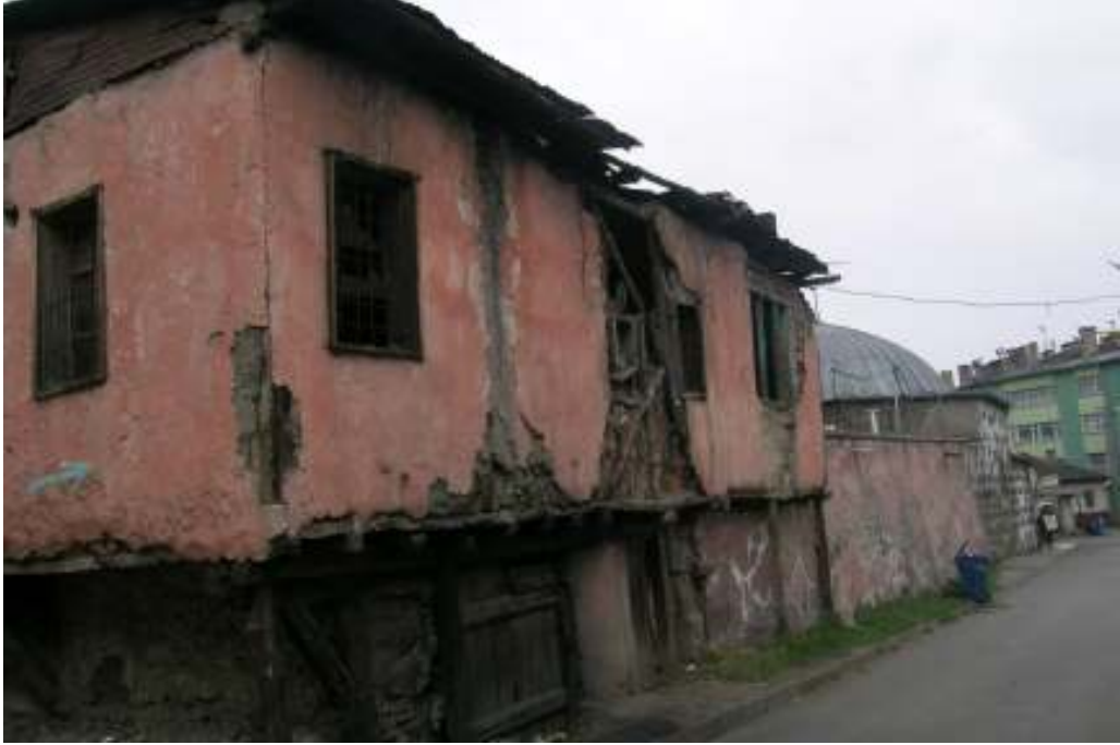
Fotoğraf:5 Eski Paşa Hamamı, güney cephe ile külhanın üstüne inşa edilmiş ev
