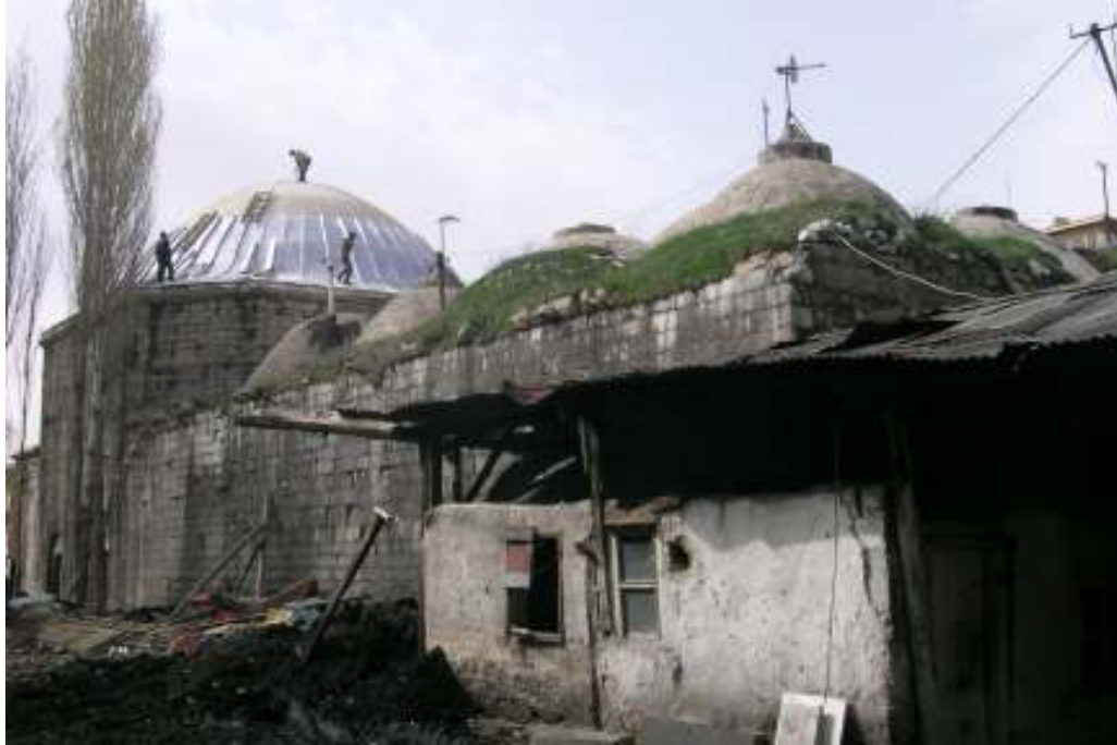
Fotoğraf: 49 Kurşunlu Hamamı, doğu cephe
