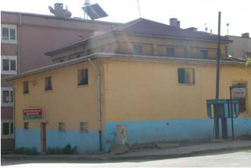
Fotoğraf: 19 Hamamcioğlu Hamamı, soyunmalık mekânı dıştan genel görünüş
