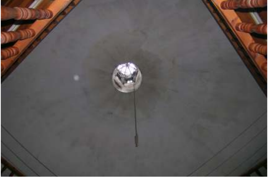
Fotoğraf:113 Meydan Hamamı, soyunmalık mekânı kubbesi ile aydınlık fenerinin içten görünüşü
