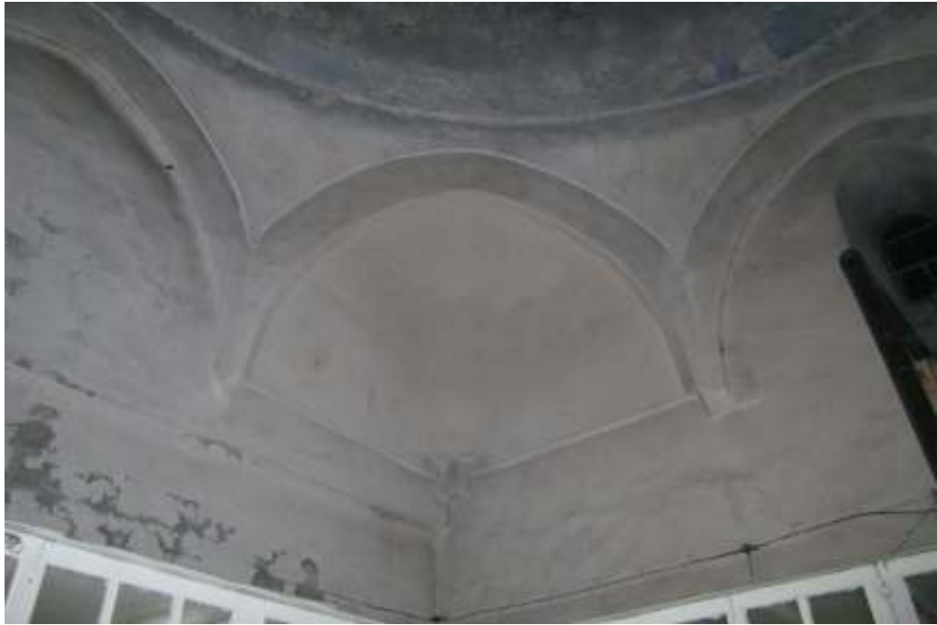
Fotoğraf: 66 Kurşunlu Hamamı, kadınlar kısmı soyunmalık mekânı kubbe geçişleri
