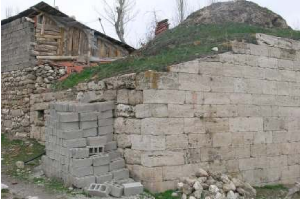
Fotoğraf:140 Pirkinik Hamamı, güney cephe
