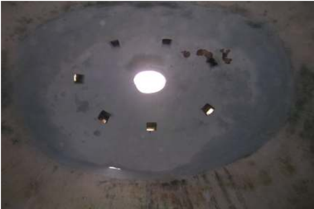
Fotoğraf: 64 Kurşunlu Hamamı, erkekler kısmı eyvanlarında elips biçimli kubbe örneği
