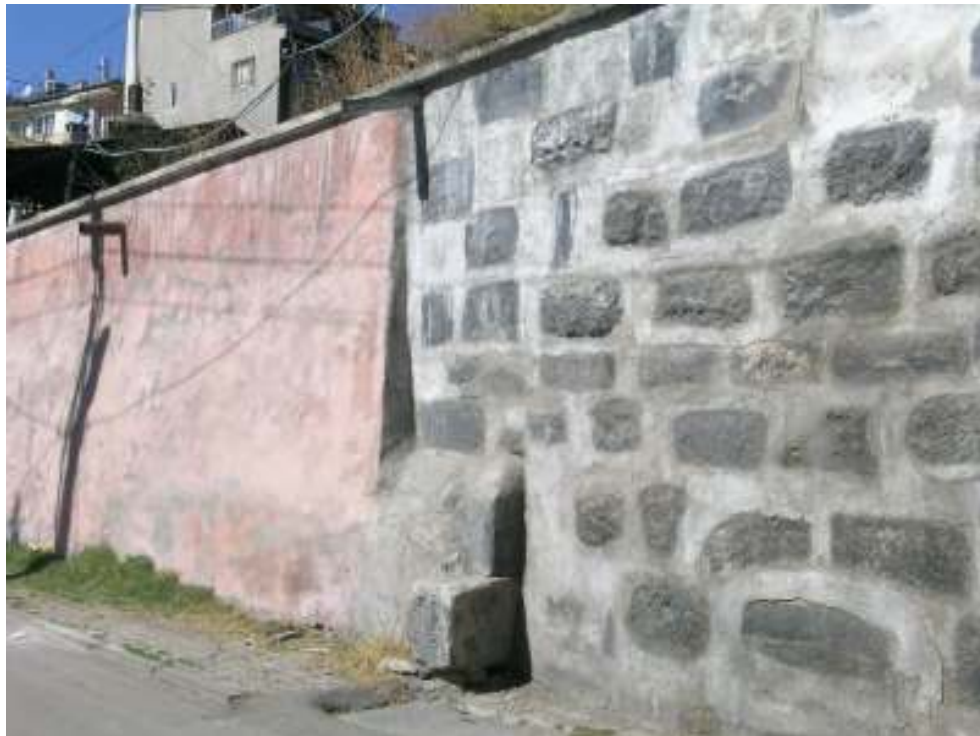
Fotoğraf: 18 Eski Paşa Hamamı, güney cephe duvar çıkıntısı
