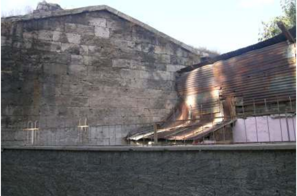
Fotoğraf: 156 Şirinoğlu Hamamı, güney cepheden bir görünüm
