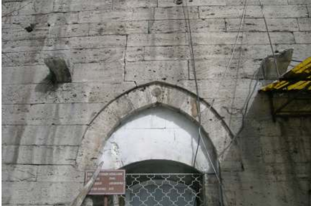
Fotoğraf: 42 Kurşunlu Hamamı erkeler kısmı soyunmalık mekânı penceresi
