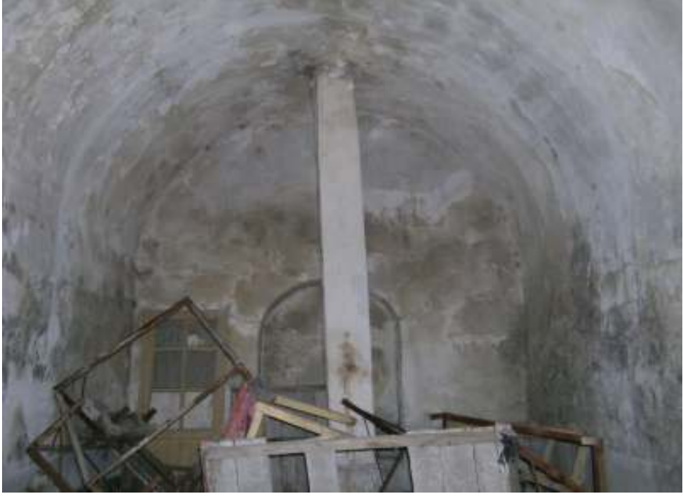
Fotoğraf: 163 Şirinoğlu Hamamı, ılıklik mekânı kuzey bölüm ile duvardaki niş
