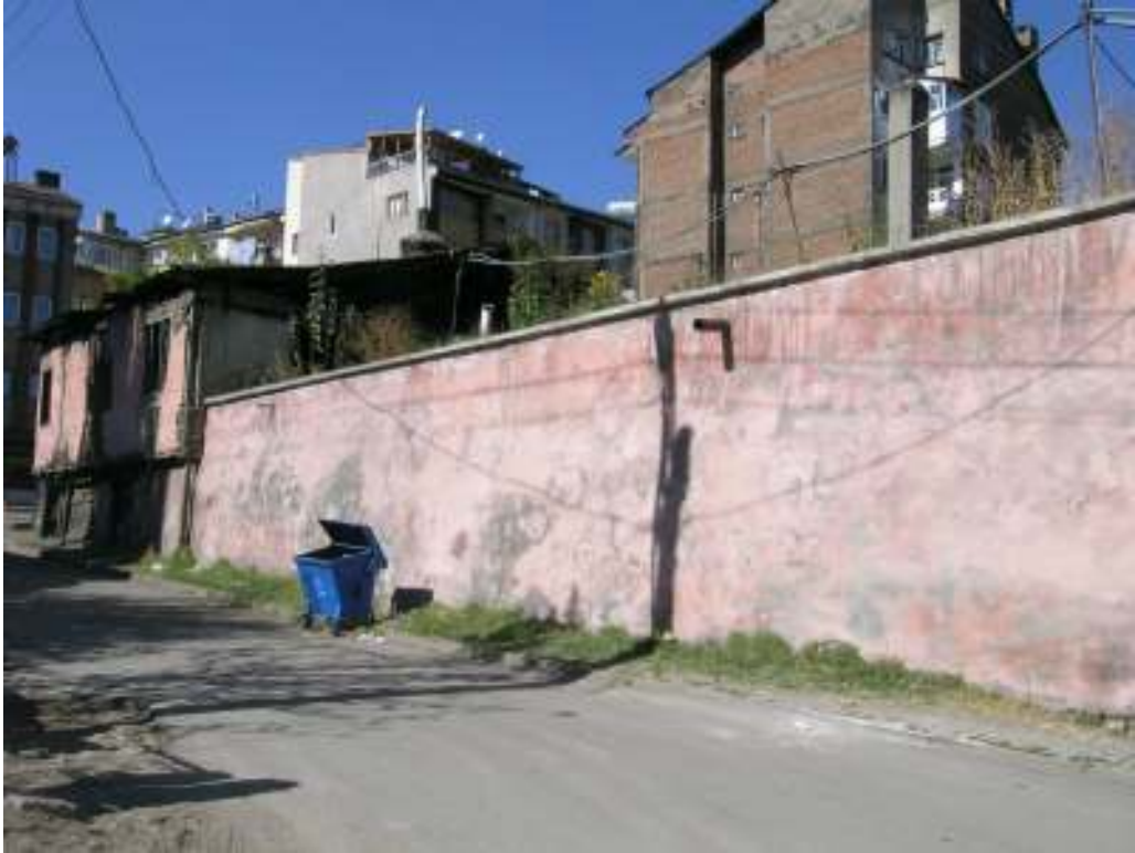
Fotoğraf: 6 Eski Paşa Hamamı, güney cephe
