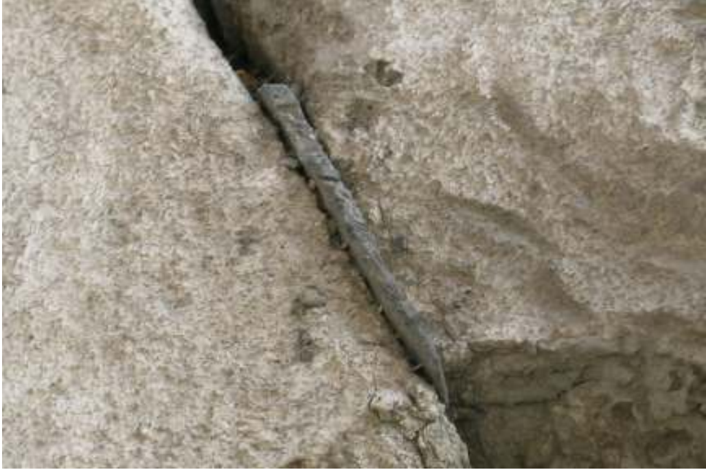
Fotoğraf: 81 Kurşunlu Hamamı, duvarlarında taşları bağlayan kurşun levhalar
