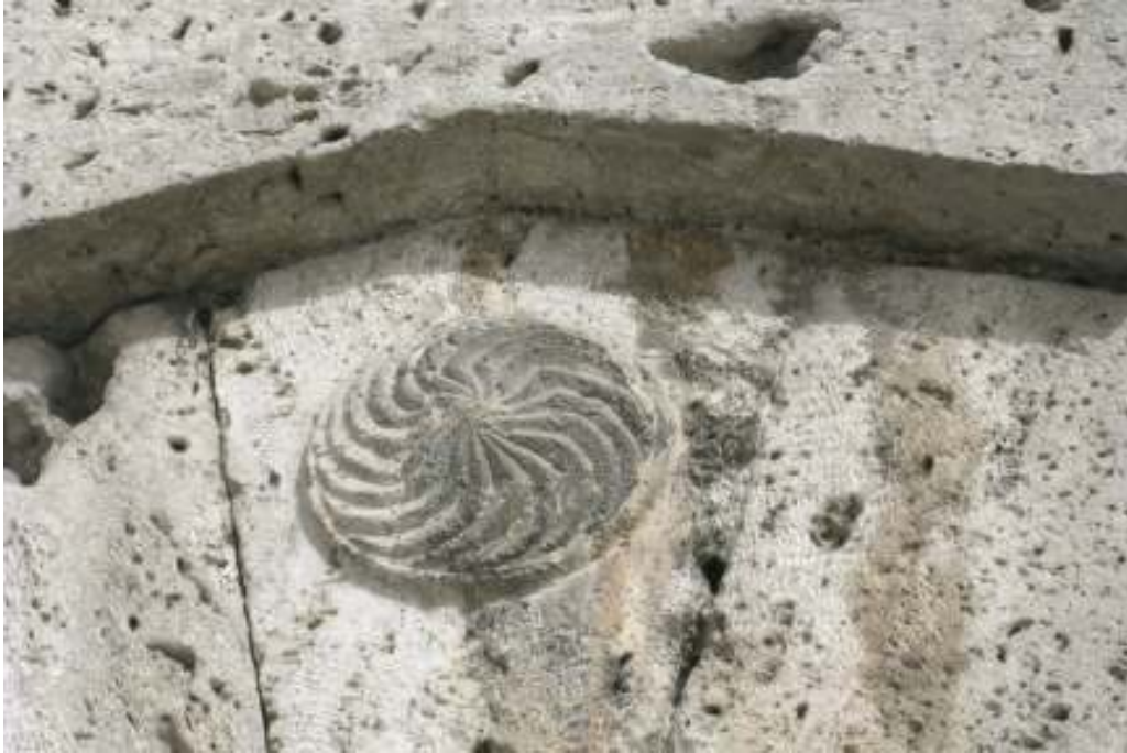
Fotoğraf: 77 Kurşunlu Hamamı, güney cephe pencere kemerinde çarkıfelek motifi
