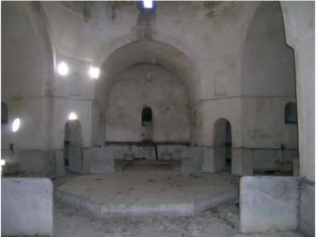
Fotoğraf: 166 Şirinoğlu Hamamı, sıcaklık mekânı
