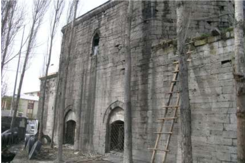
Fotoğraf: 50 Kurşunlu Hamamı, doğu cephe
