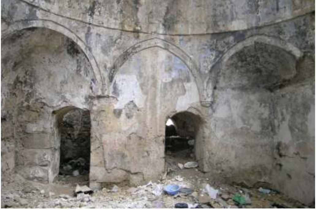
Fotoğraf: 145 Pirkinik Hamamı, soyunmalık mekânı ile kubbe geçişleri ve tıraşlığa giriş kapısı (soldaki)
