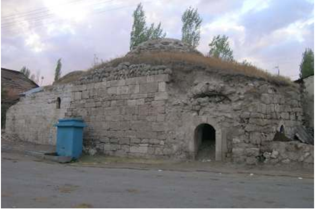
Fotoğraf: 137 Pirkinik Hamamı, doğu cephe ile giriş kapısı
