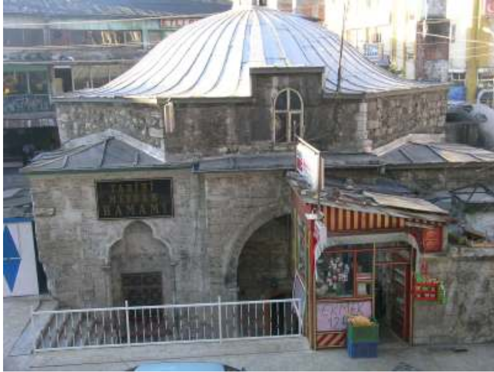
Fotoğraf:108 Meydan Hamamı, güney cephe
