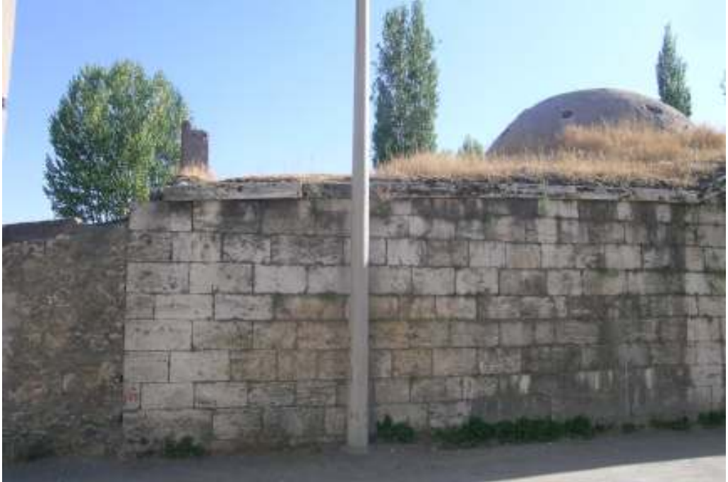
Fotoğraf:158 Şirinoğlu Hamamı kuzey cepheden bir görünüm
