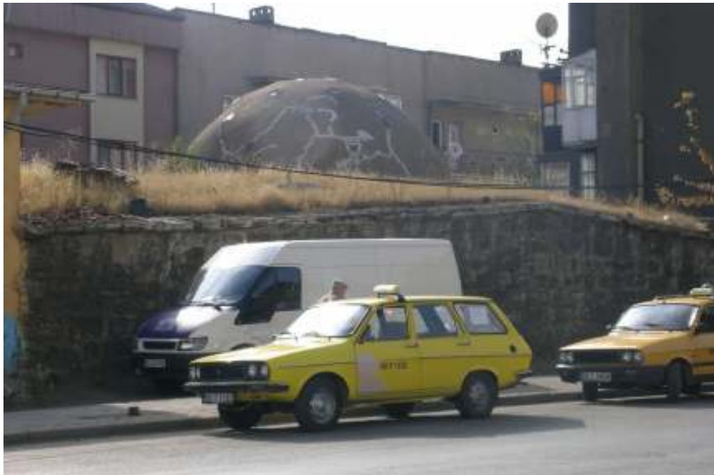
Fotoğraf: 22 Hamamcioğlu Hamamı, batı cephe
