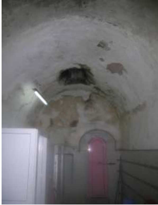
Fotoğraf: 124 Meydan Hamamı, ılıklik mekân tıraşlıklar ile helaya geçiş kapısı
