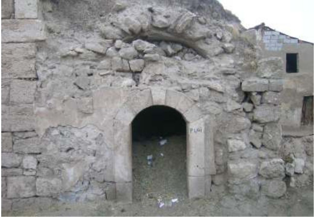
138: Pirkinik Hamamı giriş kapısı
