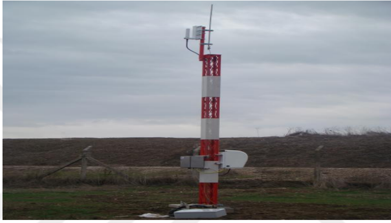
Şekil 2.10. Esenboğa MLAT Anten İstasyonu [13].
