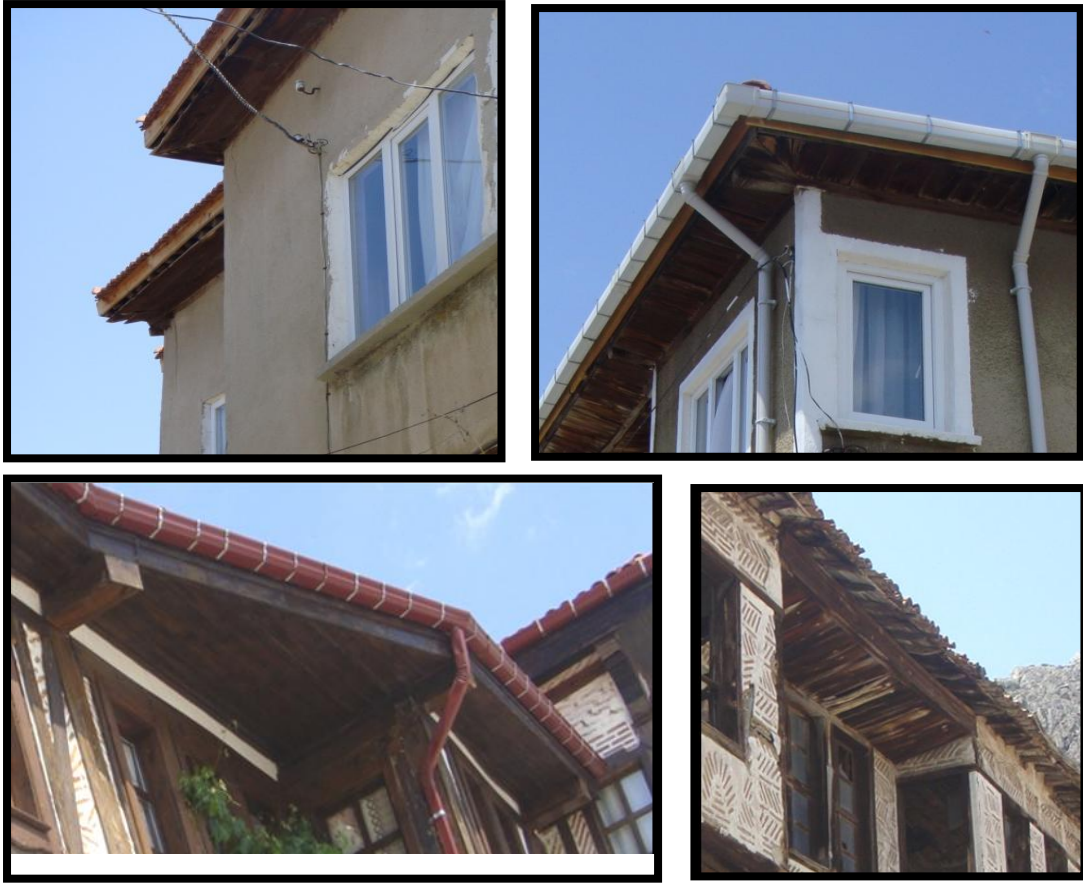
Resim 5.6. Sivrihisar evlerinden kaplamalı saçak örnekleri
