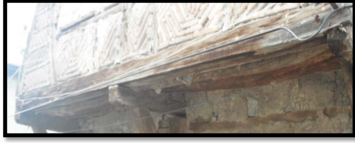
Resim 7.2. Bugün yapının dışında özensizce döşenmiş elektrik kablolarının durumu (Fotoğraflar: O. Demberel)
