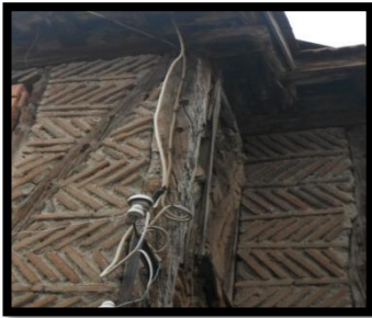
Resim 7.2. Bugün yapının dışında özensizce döşenmiş elektrik kablolarının durumu (Fotoğraflar: O. Demberel)
