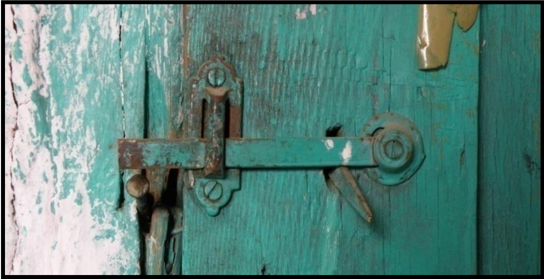
Resim 4.19. 103 oda kapısı metal eleman (Fotoğraf: O. Demberel)
