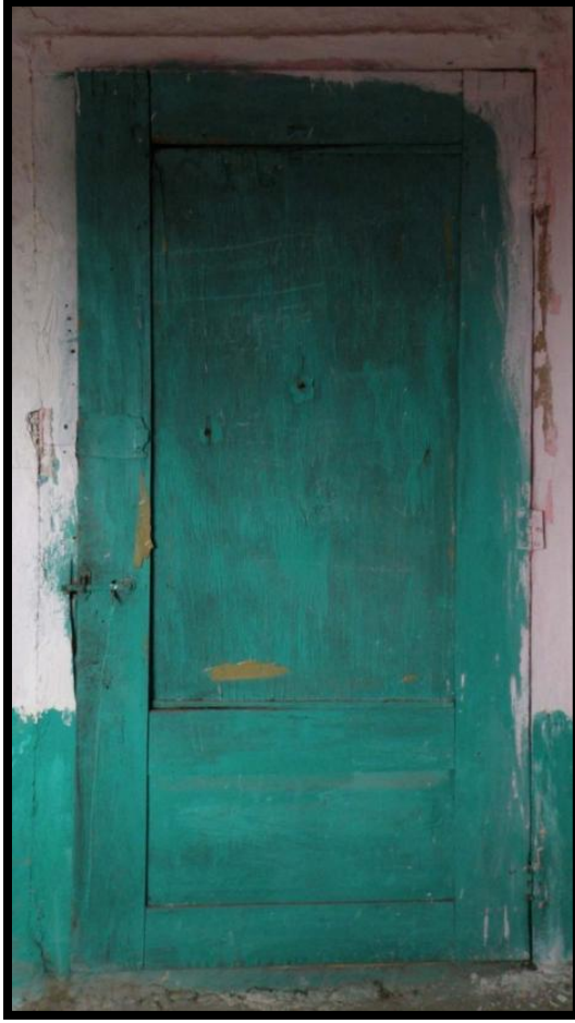
Resim 4.18. 103 oda kapısı (K.1.4) (Fotografi: O. Demberel)
