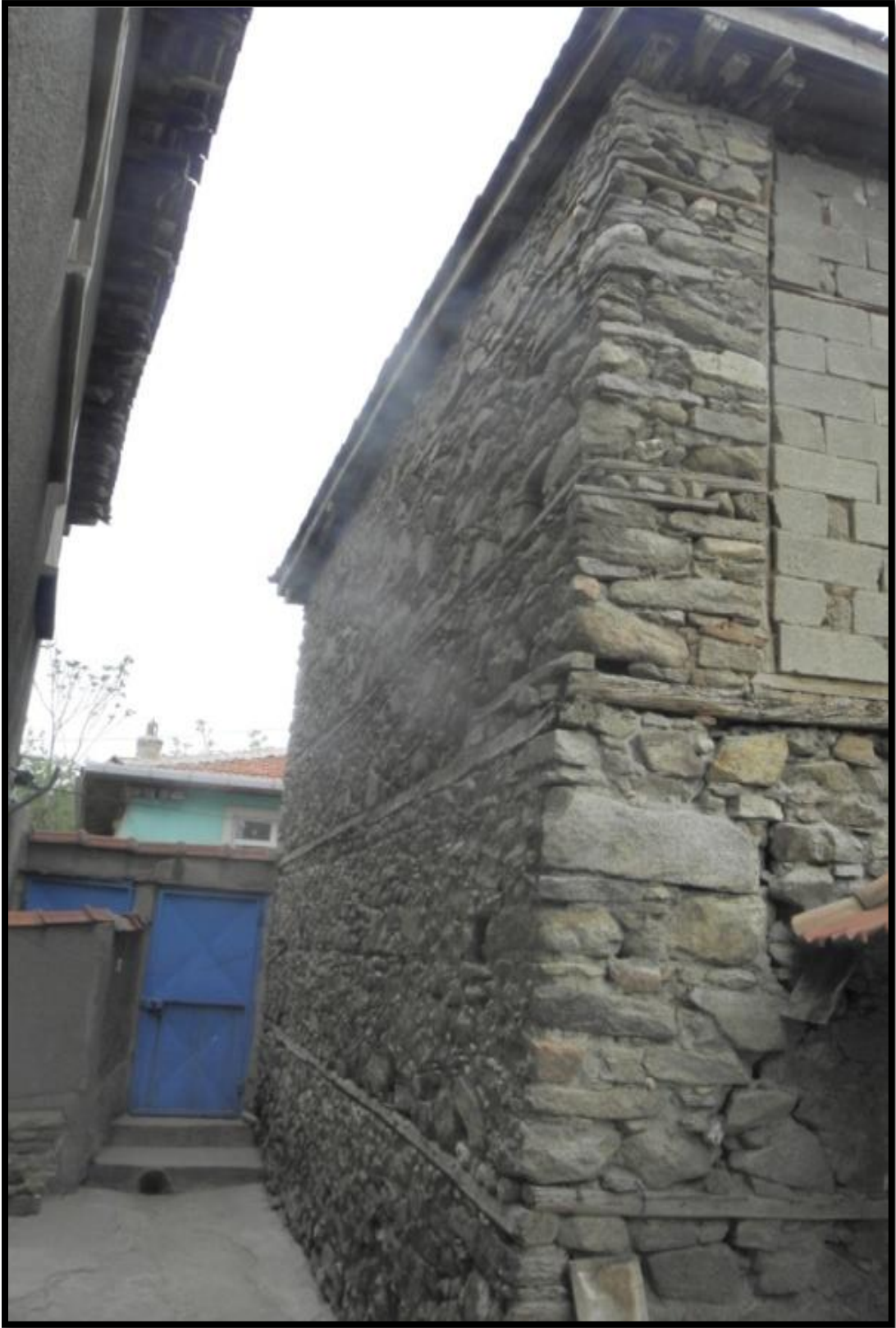
Resim 4.7. Kuzeydoğu cephesi (Fotoğrafi: O. Demberel)
