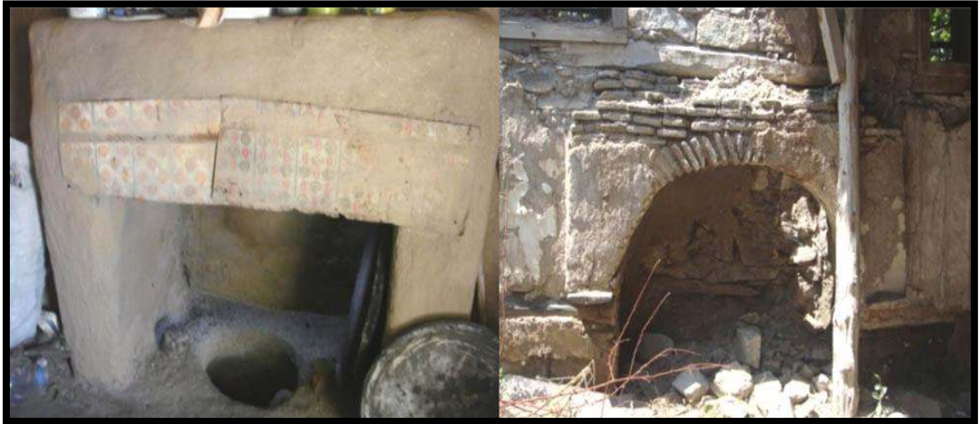
Resim 5.16. a) Tandır ocak örnek b) Avlu ocak örnek (Fotografi: O.Demberel)
