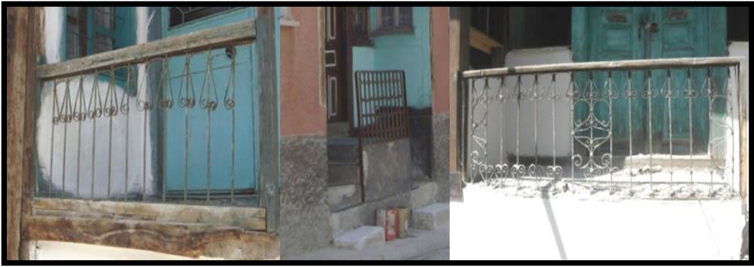
Resim 5.13. Ahşap ve metal korkuluk çeşitleri (Fotoğraf: O. Demberel)
