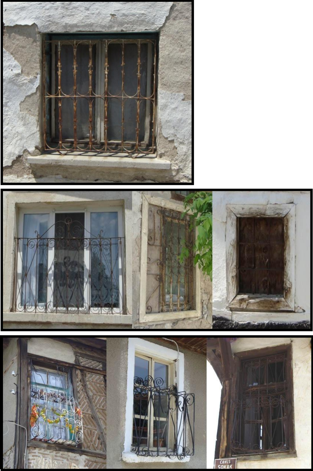
Resim 5.10. b) Sivrihisar evlerinden demir parmaklık türleri (Fotoğraf: O. Demberel)
