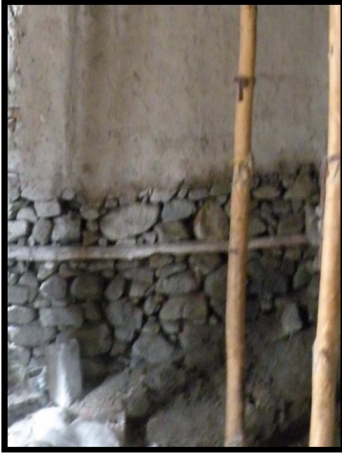
Resim 4.33. Z01 oda moloz taş duvar (Fotoğraf: O. Demberel)
