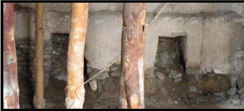
Resim 4.32. Zemin katın kuzeydoğu duvarındaki çift niş (Fotoğraf: O. Demberel)
