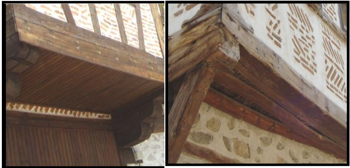
Resim 5.4. Sivrihisar evlerinde çıkma altlarının kaplamaları (Fotoğraflar: O. Demberel)
