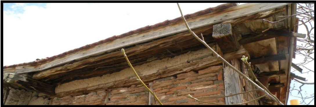
Resim 4.9. Çatı saçaklar (Fotoğraf: O. Demberel)
