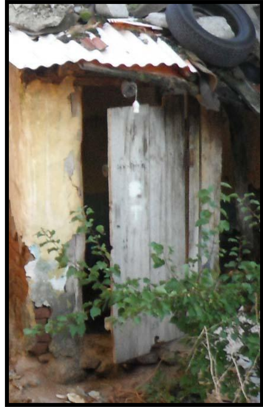
Resim 4.17. WC kapısı (K1.3) (Fotoğraf: O. Demberel)
