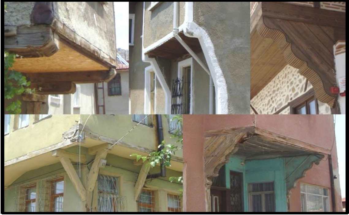
Resim 5.3. Bindirmeli ve Eli böğründe ile desteklenen çıkma örnekleri (Fotoğraflar: O. Demberel)
