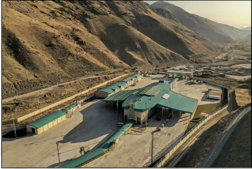
Fotoğraf 4. 14. Modernizasyon Sonrası Kapıköy Sınır Kapısı. 33
