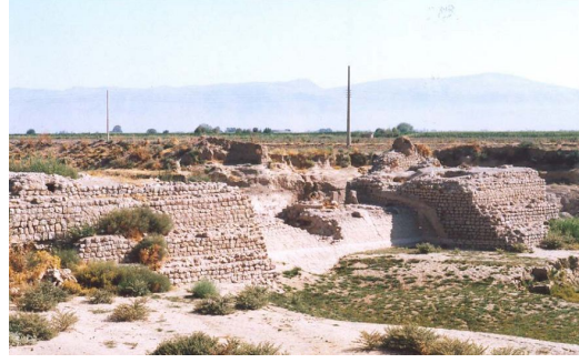
Şekil 4 Sâsânîler dönemi kurumuş Savand Nehri yatağı üzerinde Madabad Barajı kalıntıları. (M C. Malekzâdeh, 2007, s. 8)
