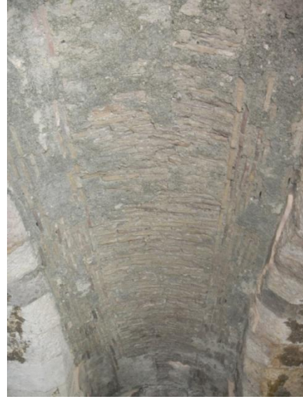
b. 2. Galeri tuğla tonoz üst örtüsü
