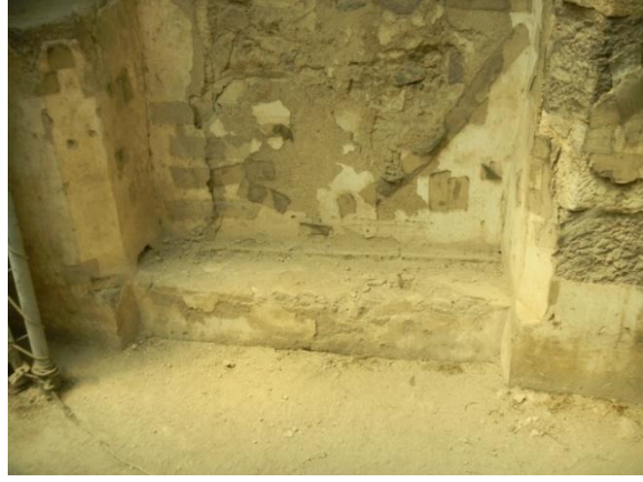
b. 2. Galeri kuzey duvar kemer ayakları arası
