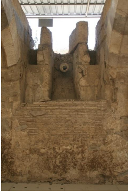
c. Bazilika teras tuğla duvar ve su iletim sistemi
