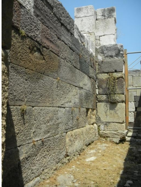
c. Bazilika Güney Duvar izler
