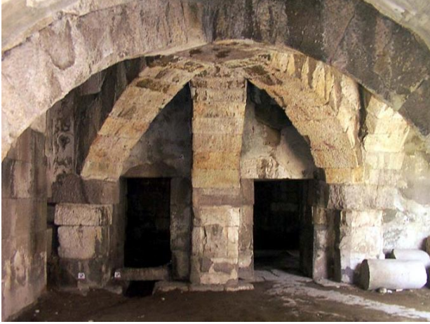
a. Batı çapraz tonoz görünüm
