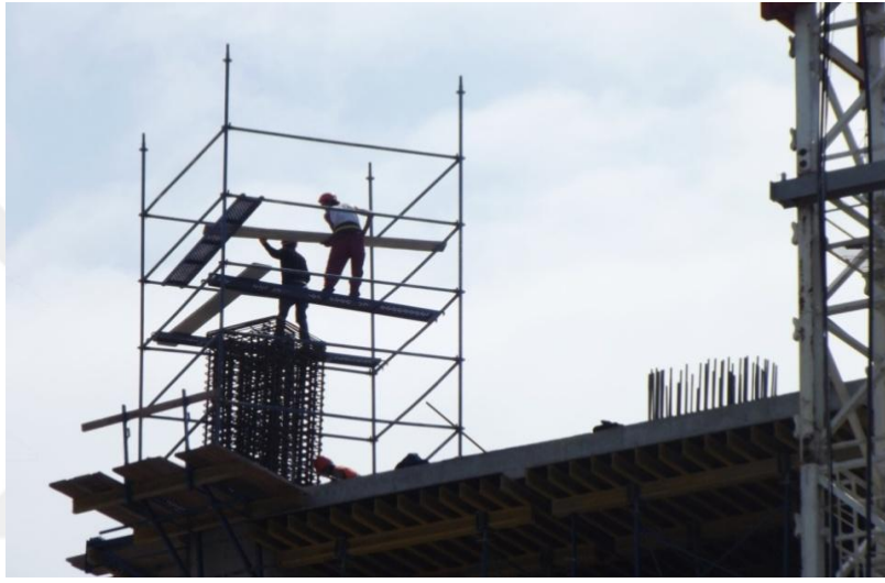
Şekil 11: Çalışan İnşaat İşçileri
