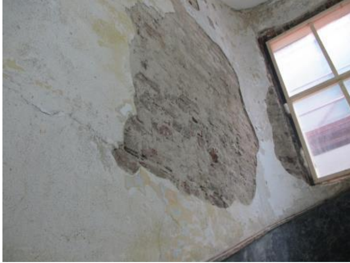
Şekil 4.70: Stük altından çıkan duvar malzemesi (Yeteroğlu, 2014)
