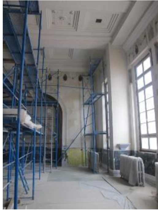
Şekil 4.49: 2014 yılı Societá Operaia restorasyon çalışmaları (Yeteroğlu, 2014)
