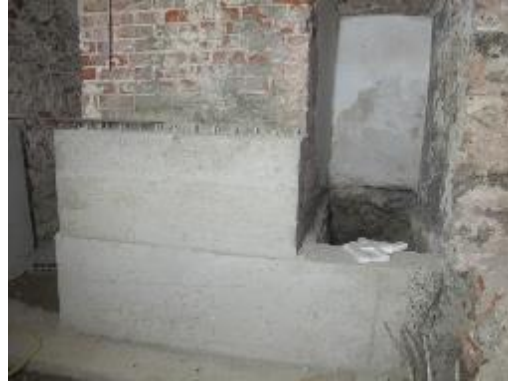
Şekil 4.4: Restorasyon çalışması bodrum kat güçlendirme (Yeteroğlu, 2014)
