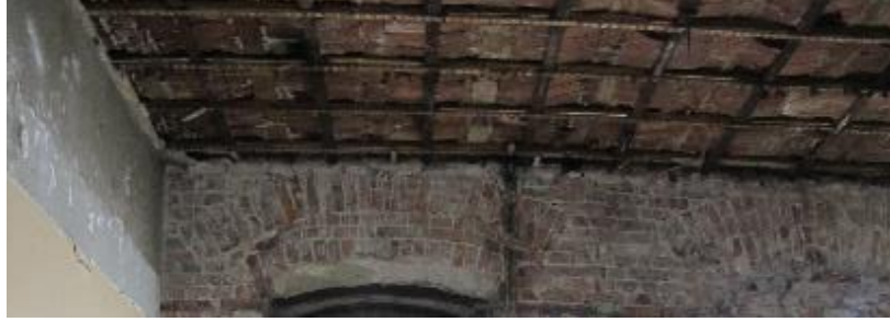
Şekil 6.1: Zemin katta yer alan demir putreller (Yeteroğlu, 2014)
