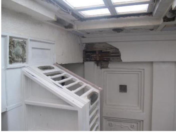
Şekil 4.69: Ortaya çıkan bağdadilerin görünümü (Yeteroğlu, 2014)
