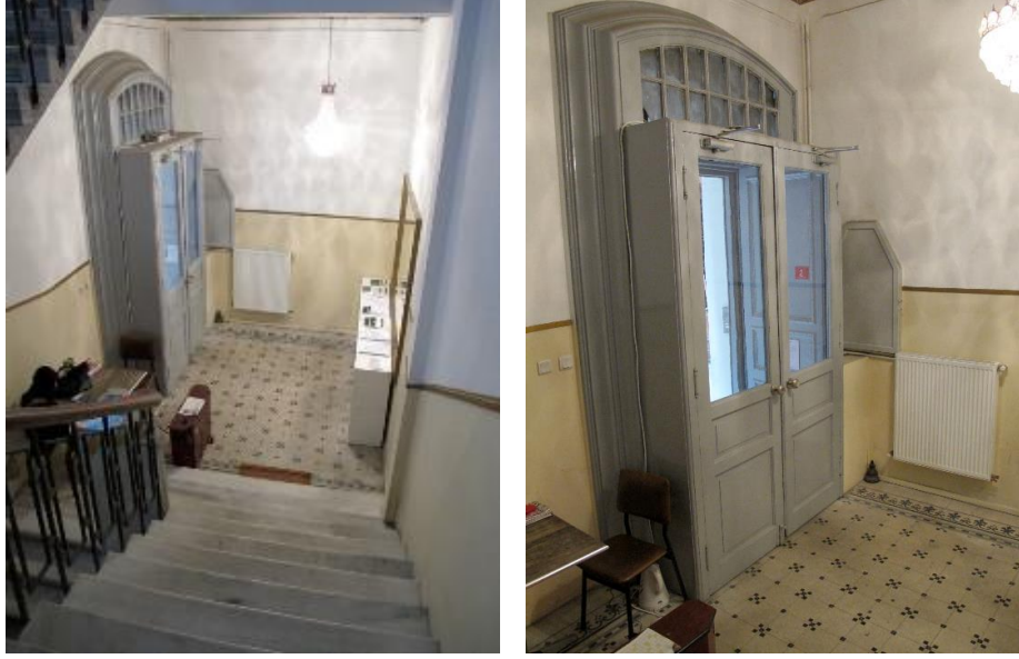
Şekil 4.15: Z01 Giriş Holü Genel Görünüm (Yeteoğlu, 2011)
