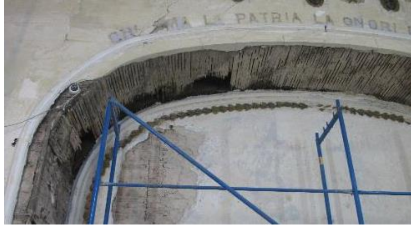
Şekil 6.2: Sahne üzerinde bağdadi çıtaların durumu (Yeteroğlu, 2014)
