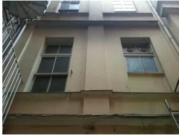
Şekil 4.80: 1. Katta yer alan ahşap giyotin pencereler (Yeteroğlu, 2011)
