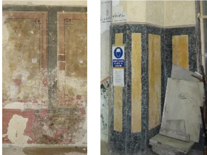
řekil 6.3: Duvar bezemesi ve stük
