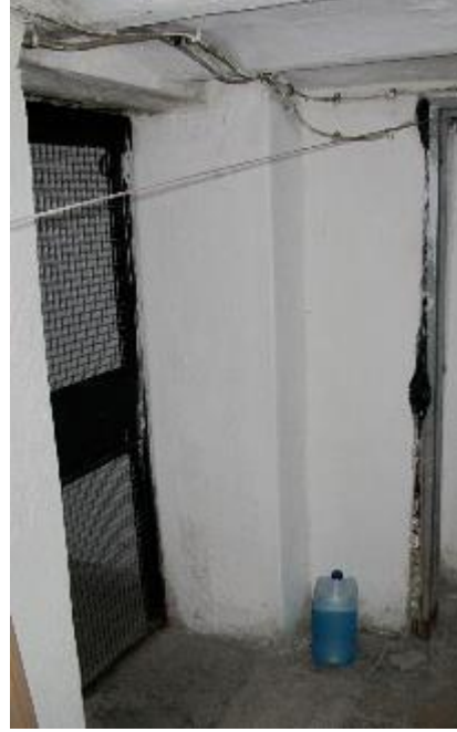
Şekil 4.12: B05 No'lu mekân Demir Kapısı (Yeteroğlu, 2011)
