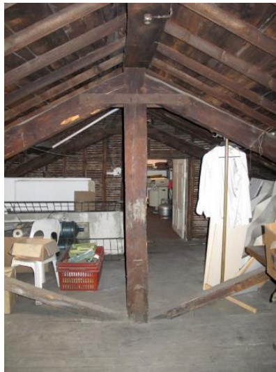
Şekil 4.63: 307 No'lu Çatı arası genel görünümü (Yeteroğlu, 2011)
