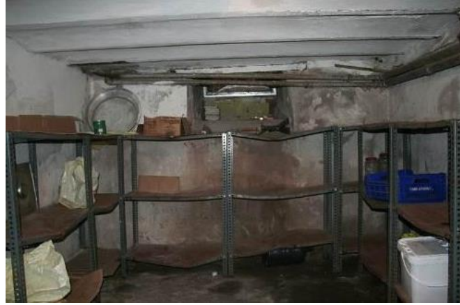
Şekil 4.6: B02 No'lu mekânın volta döşemeleri ve Güneybatı duvarı (Yeteroğlu, 2011)
