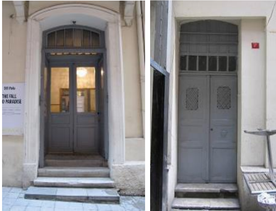
Şekil 4.78: Güneydoğu Cephesi'nde yer alan kapılar (Yeteroğlu, 2011)
