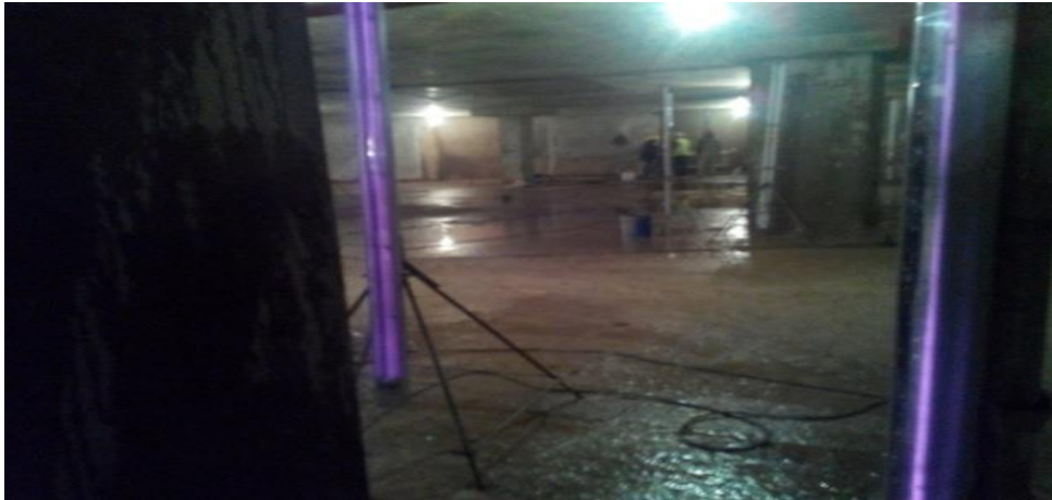
Şekil 4.6: Sıva imalatı yapılan alanda kızılötesi yüzeysel ısıtıcı kullanımı.
