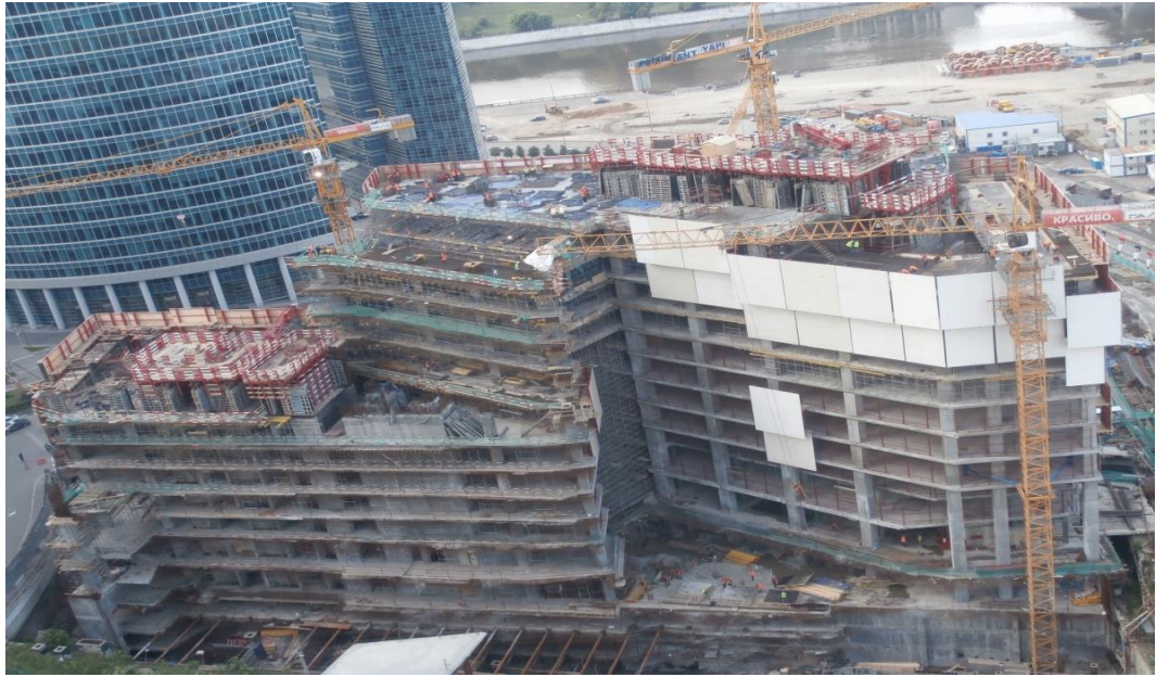
Şekil 5.1: Uygulama projesi şantiye görünümü.
