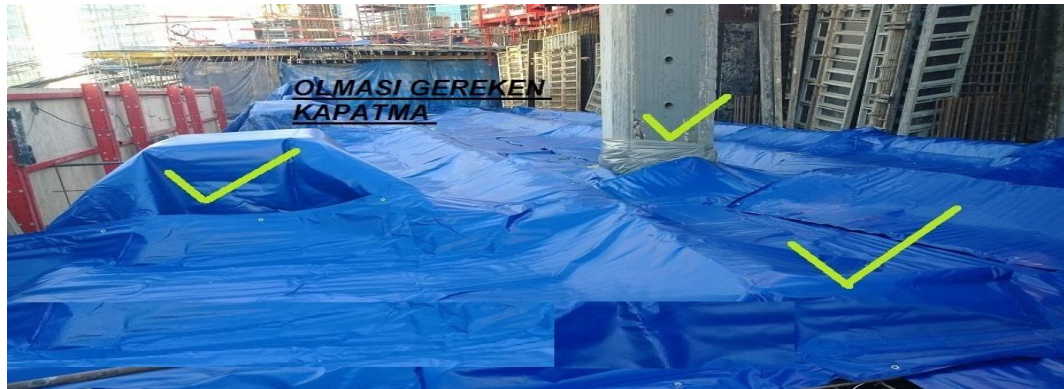
Şekil 5.25: Yüzey kapatmada uygun branda kullanımı..
