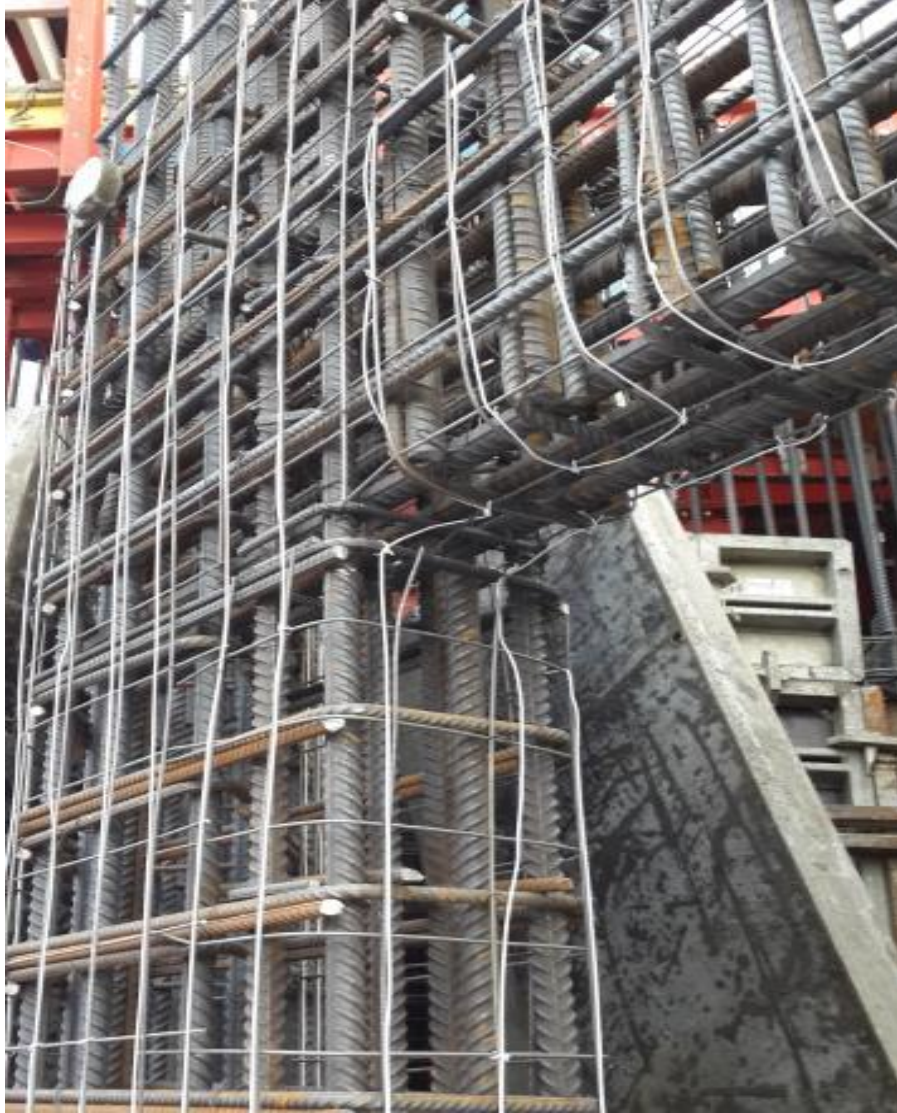
Şekil 5.6: Kolon ve kiriş üzerinde ısıtma teli montajı.
