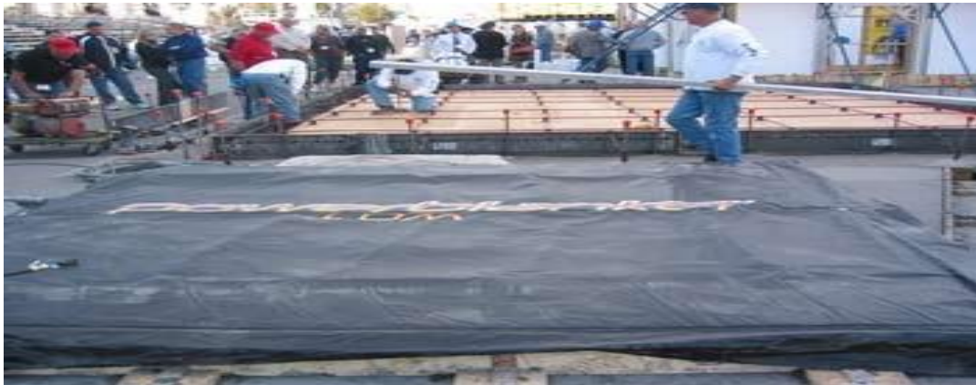
Şekil 4.1: Elektrikli ısıtma battaniyesinin uygulaması.
