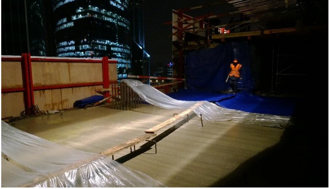
Şekil 5.24: Beton dökümüne paralel yüzeylerin kapatılması.
